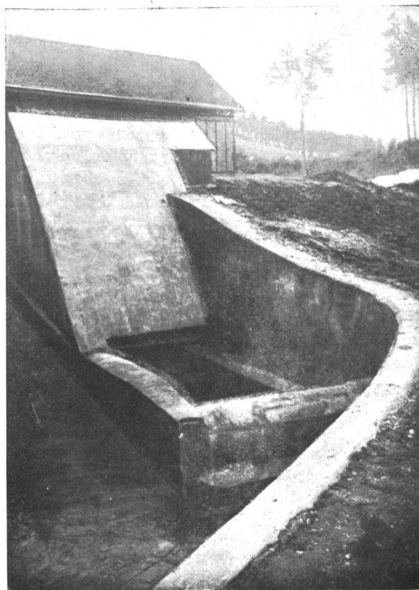
Die Wasserwerkanlage Siegesmühle bei Seon. Abbildung 4. Saugüberfall, von unten gesehen.
