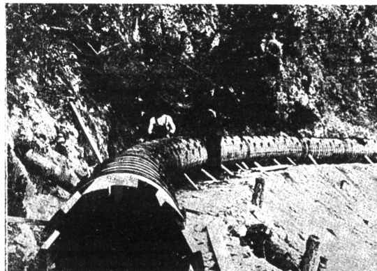
Amerikanische Druckleitung aus Holz von kleinem Durchmesser (zirka 70 cm).
