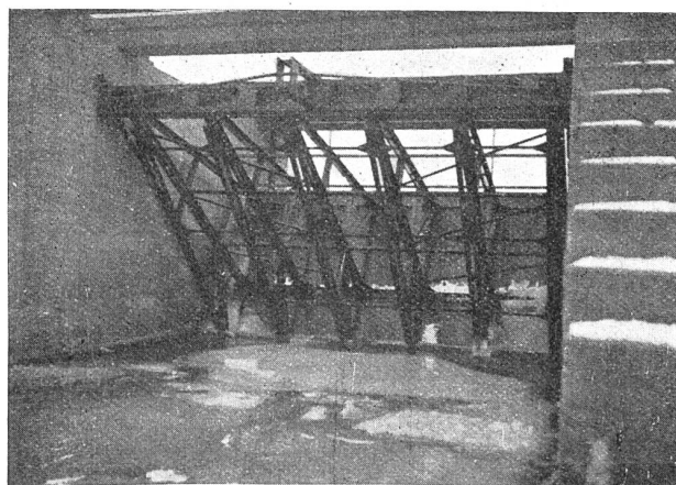
Abbildung 52. Zylinderwehr (von unten gesehen) im Rock-Fluss bei Sterling Illinois.
