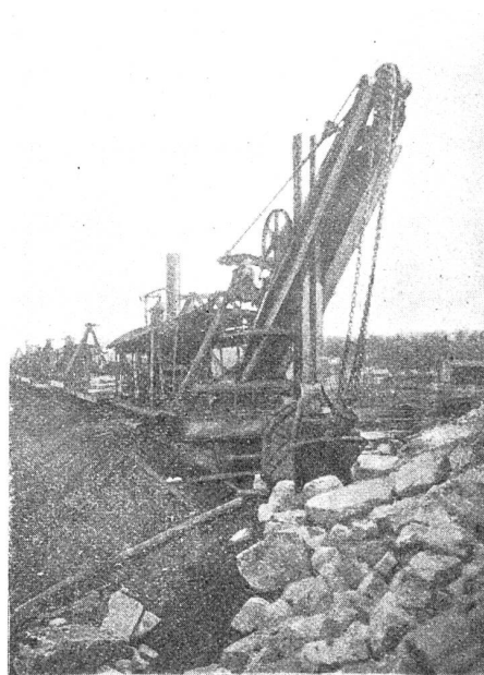
Abbildung 39. Dampfschaukel am Chicago-Entwässerungs-Kanal.
