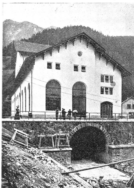
Abbildung 2. Maschinenhaus, Giebel gegen den Unterwasserkanal.
