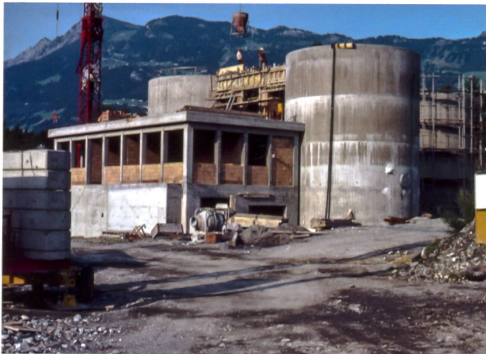
Bau von Faulanlage und Betriebsgebäude, 1977.
