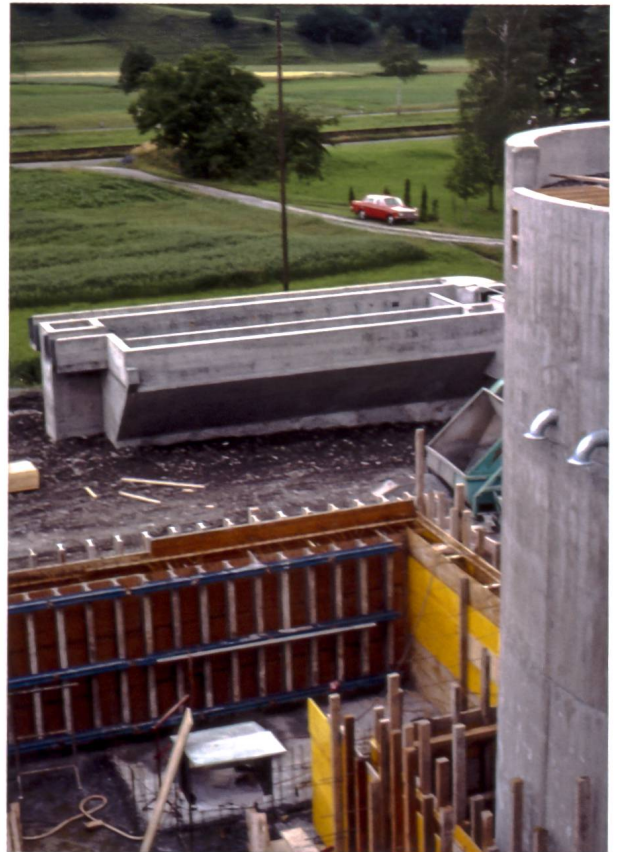
Bauarbeiten bei der ARA mit Sand- und Fettfang im Hintergrund, 1977.
