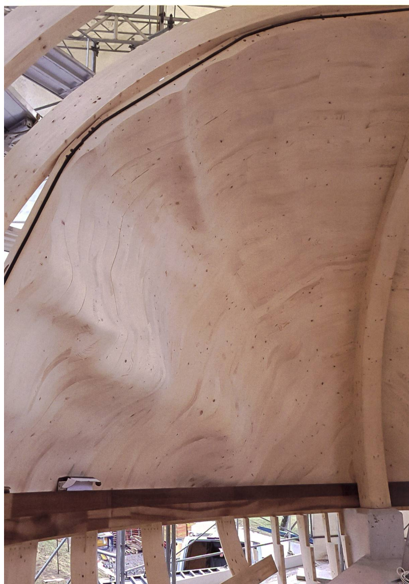
Einbau der Vertikalknaggen.
