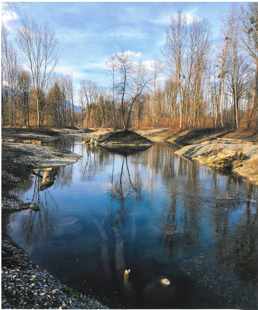
Eingebrachte Stämme als Totholzunterstände.
