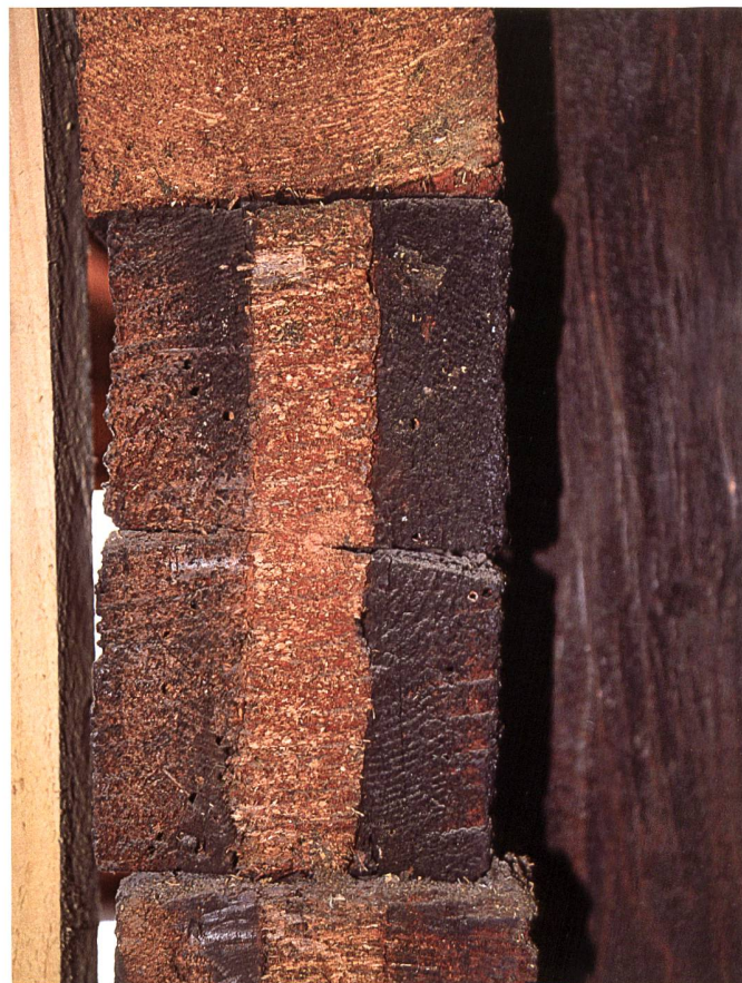
Abb. 18. Strickbalken im Obergeschoss: Die Schwärzung zieht sich noch andeutungshaft am Stummel des abgesägten Zapfens entlang.
