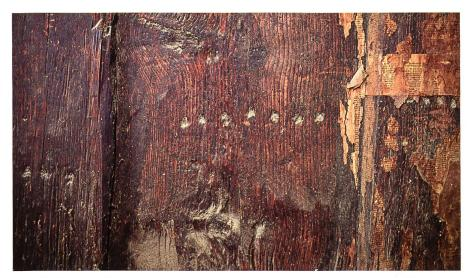
Abb. 15. Trennwand zwischen obergeschossiger Kammer und Nebenkammer. Die grob abgebeilte Stabwand zeigt zur Nebenstube hin eine feine Zählung durch Punkte; sie ist heute nicht mehr sichtbar. Foto Kunstdenkmälerinventarisation 2016, Kantonale Denkmalpflege St. Gallen
