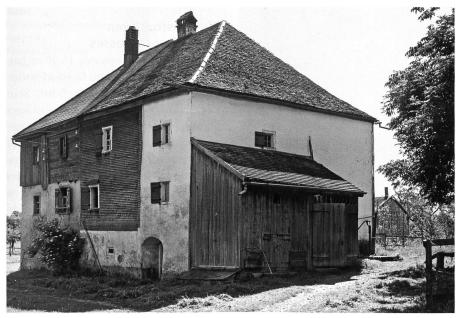
Abb. 2. Auf dieser älteren Rückansicht (um 1955) sind mit verschiedenen Bautechniken auch verschiedene Bauphasen ablesbar. Der hinterste Hausteil zeigt eine flüchtige Bohlenverschalung, davor sind obergeschossig Strickbalken zu erkennen. Auch in der vorderen Haushälfte deutet ein tief heruntergezogener Schindelschirm auf Holzbauweise im Anstoss an Massivbauweise hin. Foto H. Schmidt, Bad Ragaz, Kantonale Denkmalpflege St.Gallen
