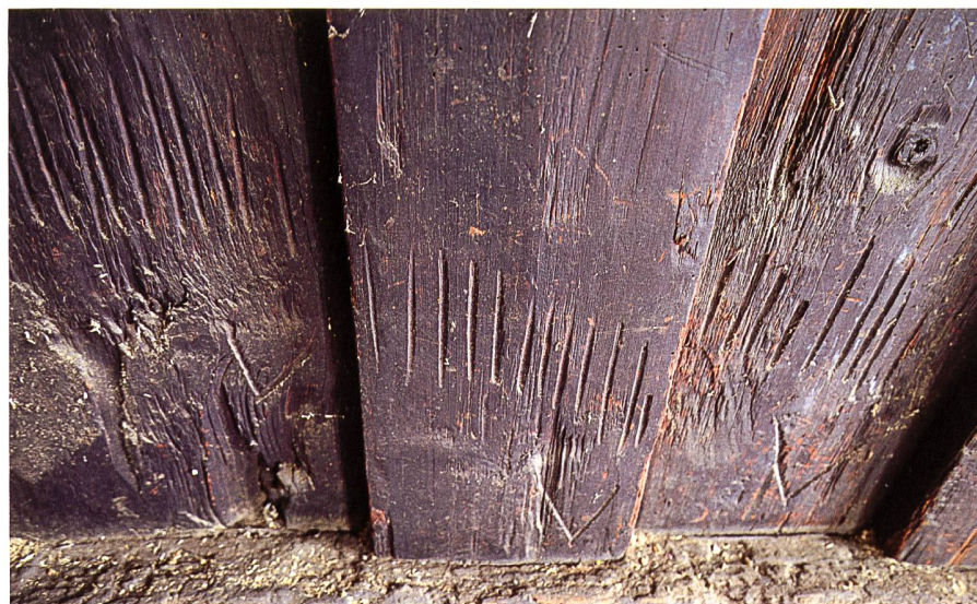
Abb. 16. Die gleiche Trennwand in ihrer Ansicht zur Kammer; sie zeigt eine grob eingearbeitete Strichzählung über dem Wandzeichen «V».
