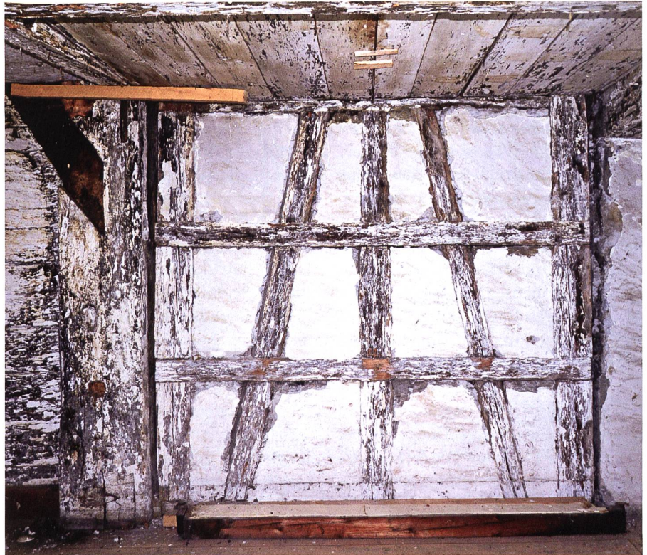
Abb. 8. Das Kopfband des westlichen Eckständers ist hoch angesetzt und gerade geführt; es unterscheidet sich damit erheblich vom nördlichen Eckständer. Die deutlich auf Abstand gesetzte Fachwerkwand entstand erst 1809 und führte auf einen damals neu geschaffenen Eingang zu (Bildrand rechts).
