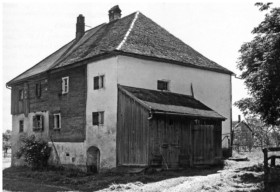
Abb. 2. Auf dieser älteren Rückansicht (um 1955) sind mit verschiedenen Bautechniken auch verschiedene Bauphasen ablesbar. Der hinterste Hausteil zeigt eine flüchtige Bohlenverschalung, davor sind obergeschossig Strickbalken zu erkennen. Auch in der vorderen Haushälfte deutet ein tief heruntergezogener Schindelschirm auf Holzbauweise im Anstoss an Massivbauweise hin. Foto H. Schmidt, Bad Ragaz, Kantonale Denkmalpflege St.Gallen
