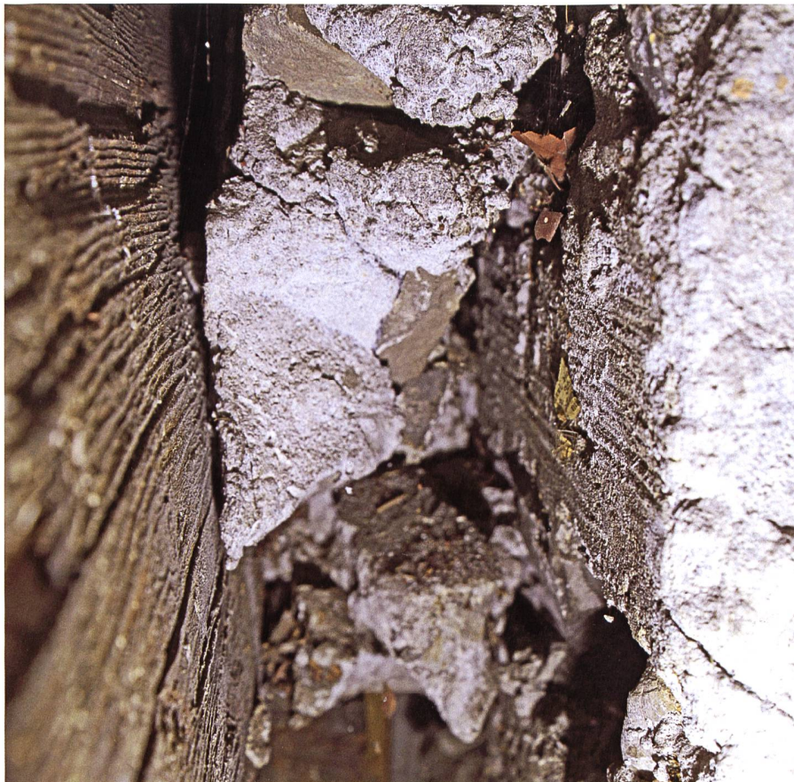
Abb. 19. Passgenauer Abdruck der Strickbalken (links) im ehemals frischen Setzmörtel (rechts). Foto Kunstdenkmälerinventarisierung 2016, Kantonale Denkmalpflege St.Gallen
