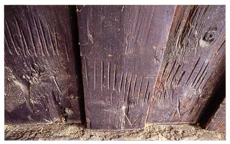
Abb. 16. Die gleiche Trennwand in ihrer Ansicht zur Kammer; sie zeigt eine grob eingearbeitete Strichzählung über dem Wandzeichen «V».
