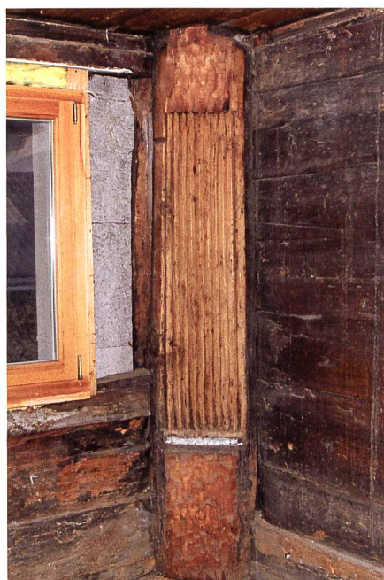
Abb. 10. Nord- und Südständer (im Bild) waren reich dekoriert; allerdings ist die Form des um 1339 erstellten Nordständers aufgrund des Brandschadens schwer ablesbar.
