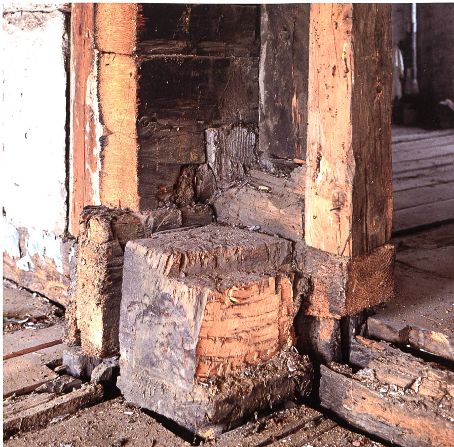
Abb. 14. Westlicher Eckständer im Obergeschoss, Zustand 2016. Unten sichtbar die Nuten des Eckständers des Bohlenständerbau, auf den die neu bearbeiteten Strickbalken versetzt wurden. Da der hintere Teil des Eckständers noch höher erhalten blieb, treppte man die Strickbalken entsprechend ab.
