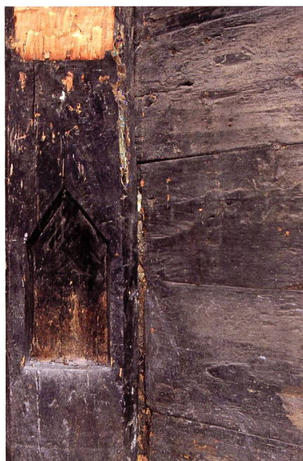
Abb. 11. Die sich diagonal gegenüberstehenden Ständer waren offenbar in gleicher Weise gestaltet: Ost- und Westständer waren schlicht abgeschrägt, der westliche (im Bild) durch eine Nische geöffnet.
