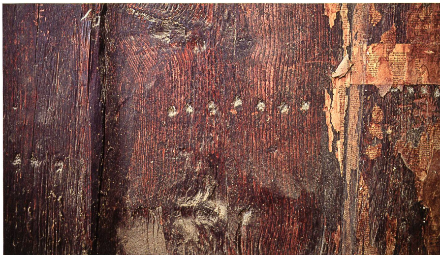
Abb. 15. Trennwand zwischen obergeschossiger Kammer und Nebenkammer. Die grob abgebeilte Stabwand zeigt zur Nebenkammer hin eine feine Zählung durch Punkte; sie ist heute nicht mehr sichtbar. Foto Kunstdenkmälerinventarisierung 2016, Kantonale Denkmalpflege St.Gallen
