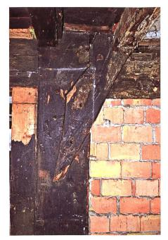
Abb. 7. Der nördliche Eckständer des Bohlenständerbaus wurde durch lange Kopfbänder mit schwalbenschwanzförmigem Blatt versteift – beide Bauteile zeigen die an der Ständerkonstruktion bislang einzigen Abbundzeichen «v». Der im Bild rechts anschliessende Ankerbalken gehört ursprünglich nicht zur Konstruktion.
