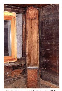
Abb. 10. Nord- und Südständer (im Bild) waren reich dekoriert; allerdings ist die Form des um 1339 erstellten Nordständers aufgrund des Brandschadens schwer ablesbar.
