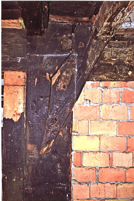
Abb. 7. Der nördliche Eckständer des Bohlenständerbaus wurde durch lange Kopfbänder mit schwalbenschwanzförmigem Blatt versteift – beide Bauteile zeigen die an der Ständerkonstruktion bislang einzigen Abbundzeichen «v». Der im Bild rechts anschliessende Ankerbalken gehört ursprünglich nicht zur Konstruktion.
