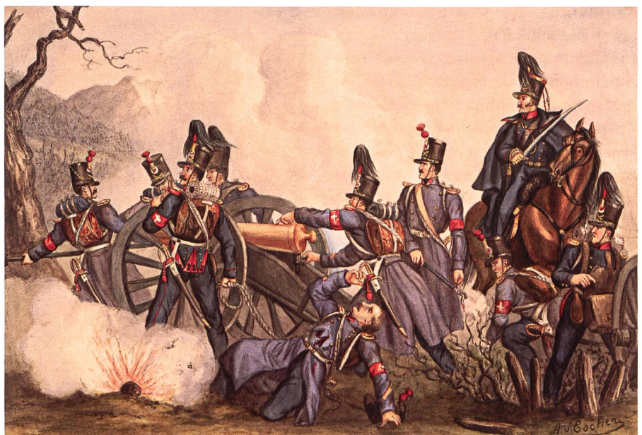
Die Solothurner Batterie Rust im Kampf bei Gisikon: Der erste Schuss bewirkte die Flucht von mehr als der Hälfte der Sonderbundsartillerie, so dass ihnen nur noch drei Geschütze blieben, die unter Hauptmann Mazzola jedoch heftigen Widerstand leisteten.
