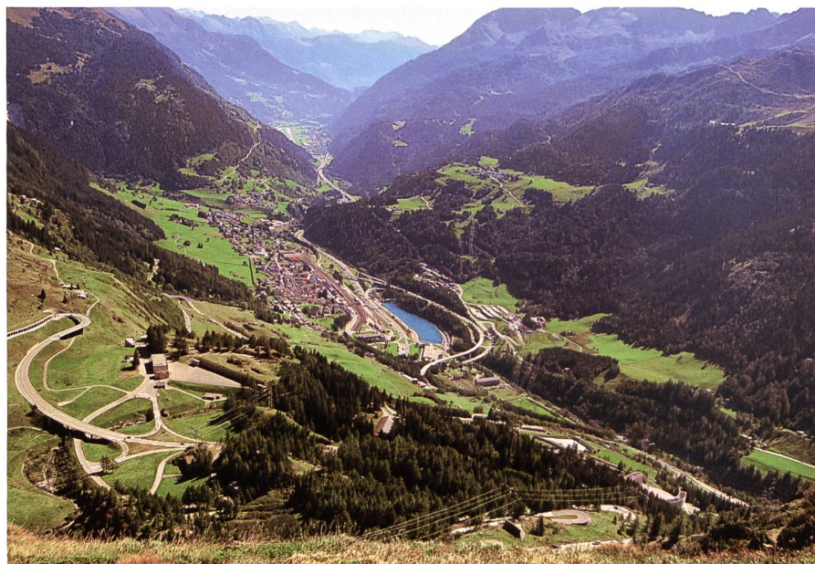
Das 1890 errichtete Artilleriewerk Motto Bartola am Eingang zur Tremola mit Blick auf Airolo und in die Leventina. Public-Domain
