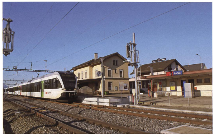
Die Gleisanlagen von Au sind inzwischen auf ein Minimum reduziert. Es bleiben noch die Funktionen einer Haltestelle und Kreuzungsstation. Foto Anton Heer, 25. April 2013
