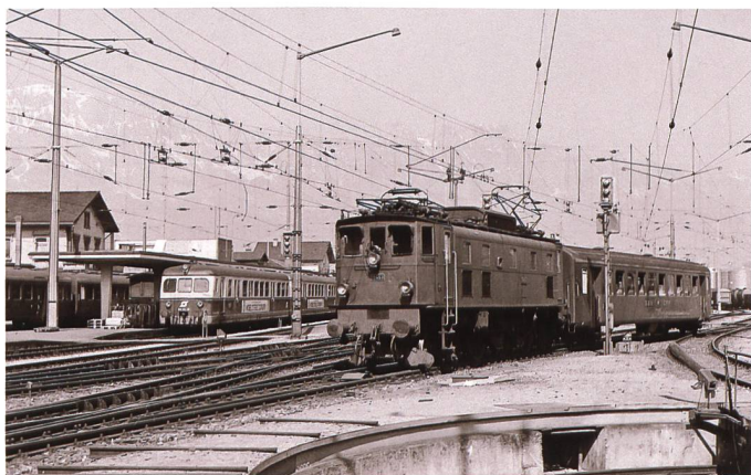
Die letzten Reste der Bahnhofbauten von Buchs aus dem Jahr 1873 sind noch sichtbar. Die einst für Buchs typischen Fahrleitungsgehänge gingen auf die Modernisierung der 1950er Jahre zurück. Foto Daniel Heer, 1. April 1976
