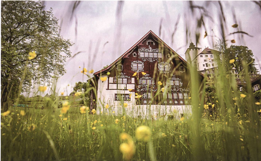
Gut erkennbar: die drei Bauphasen des Schlangenhauses vom 13. bis ins 18. Jahrhundert.
