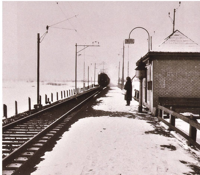
Haltestelle Weite-Wartau um 1950: Zwar wurde hier nie Lonna-Schotter verladen, dafür warteten in den 1930er Jahren die Kleinpflanzler in Handwagen-Kolonnen auf den «Powärli-Zug». Aus Vincenz et al. 2009
