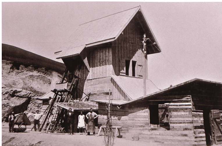
Der Steinbruch an der Lonna in den frühen 1920er Jahren: Die mehrere Meter mächtige Löss-Schicht über dem Gestein musste zuerst in wenig einträglicher Handarbeit abgetragen werden, bevor das Gestein gesprengt und dem elektrisch betriebenen Brecher zugeführt werden konnte. Bild bei Hans Senn, Azmoos
