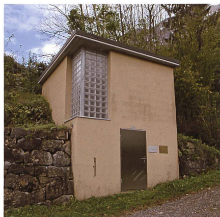
Das Ende der 1940er Jahre von der Hydranten- und Wasserversorgungskorporation Frümssen gebaute Niederzonenreservoir im Obergrüt. Foto Hans Jakob Reich, Salez
