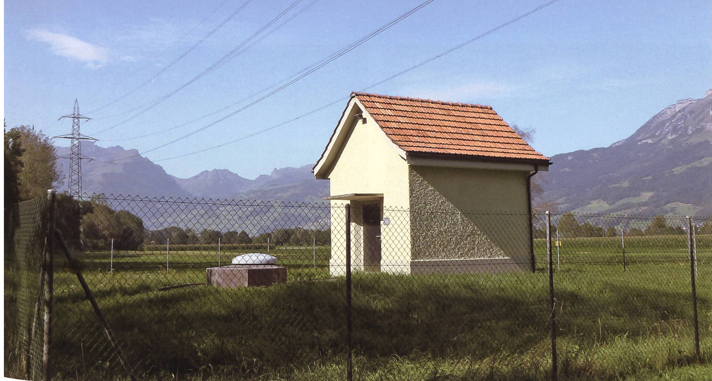
150 Meter vom Rheindamm entfernt, hart am alten Rheindamm (Lettendamm) gelegen: das Salezer Pumpenhäuschen.
