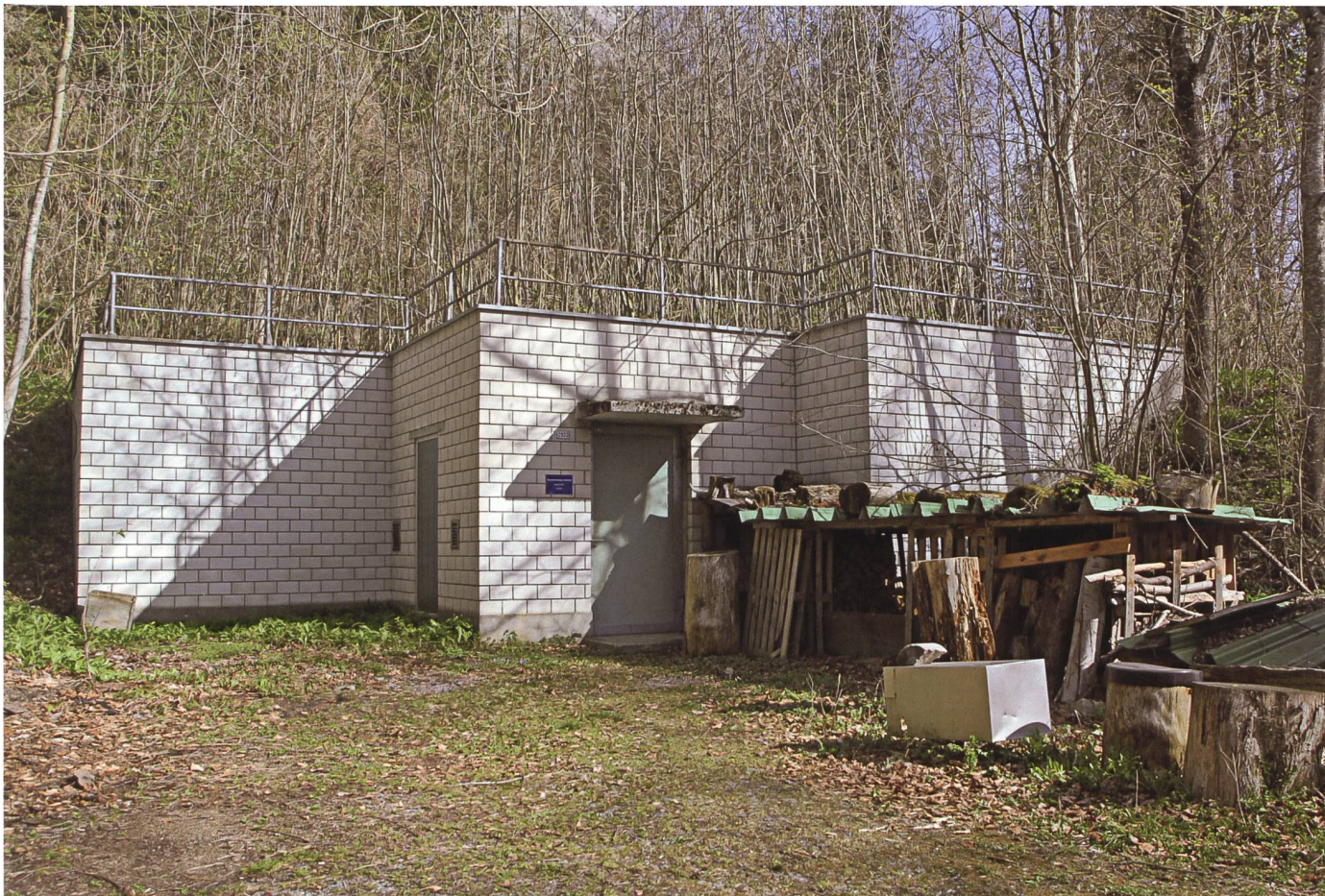
Das Reservoir Rüti am Sennwalder Berg auf 600 m ü.M. wurde 1975/76 für die Versorgung der Hochzone mit Trink- und Löschwasser gebaut. Foto Hans Jakob Reich, Salez
