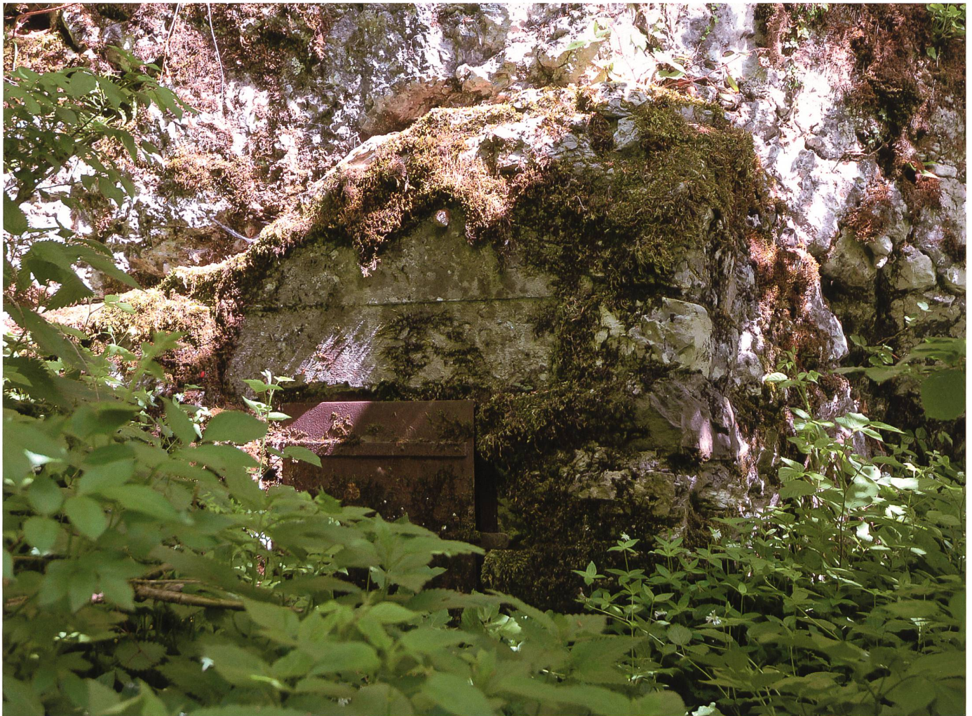
Quellfassung der Brunnengenossenschaft Understein im Brunnentobel, zirka 700 m ü. M. Das Wasser dieser Quelle speist heute den Brunnen am Weg zur Gerstere (vgl. nachstehende ganzseitige Abbildung). Foto Hans Jakob Reich, Salez
