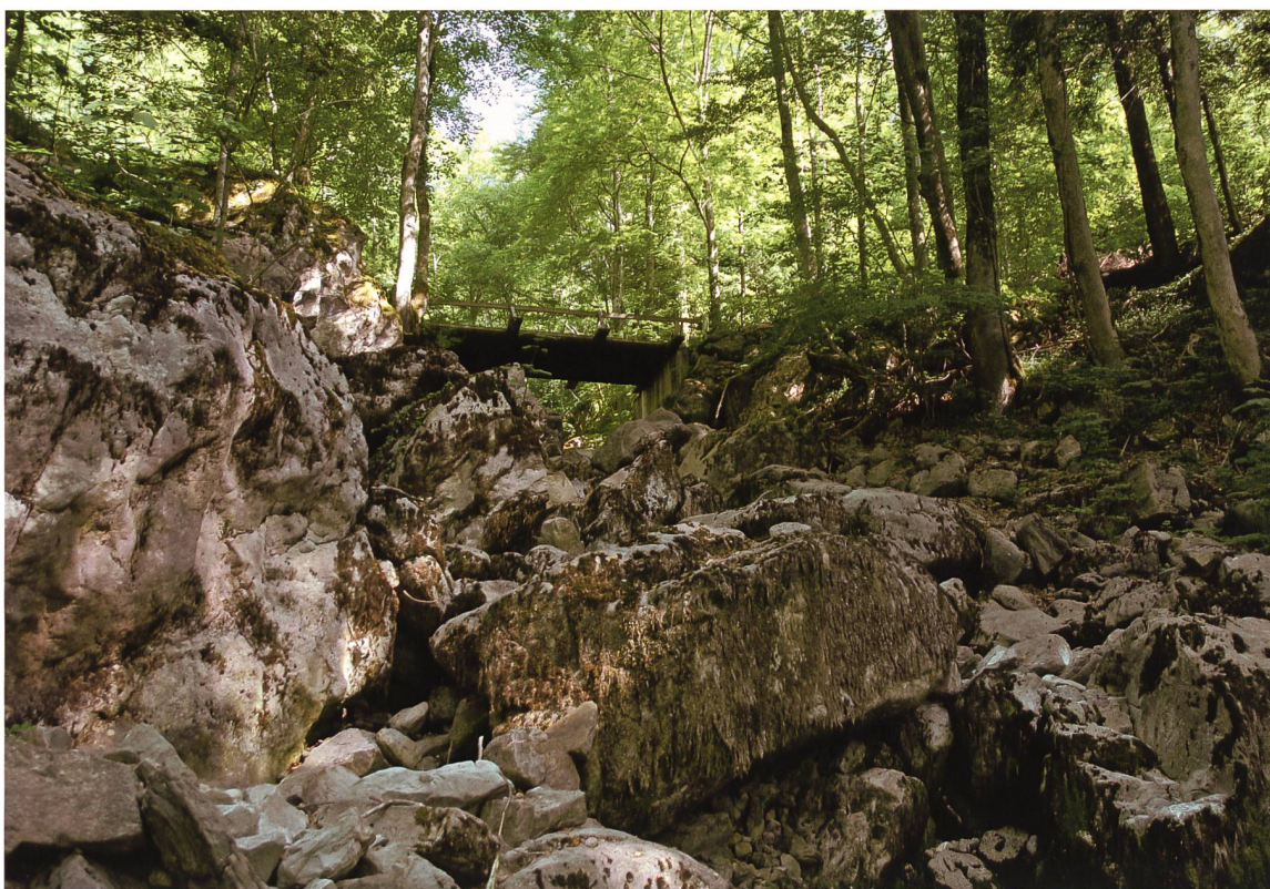
Unter der Brücke bei der Bergmühle: Hier zerstörte im Februar 1877 ein Hochwasser die Bachfassung der Zubengenossen der Rhode Läui und löste einen jahrelangen Rechtsstreit mit den Wasserwerk- besitzern aus.
