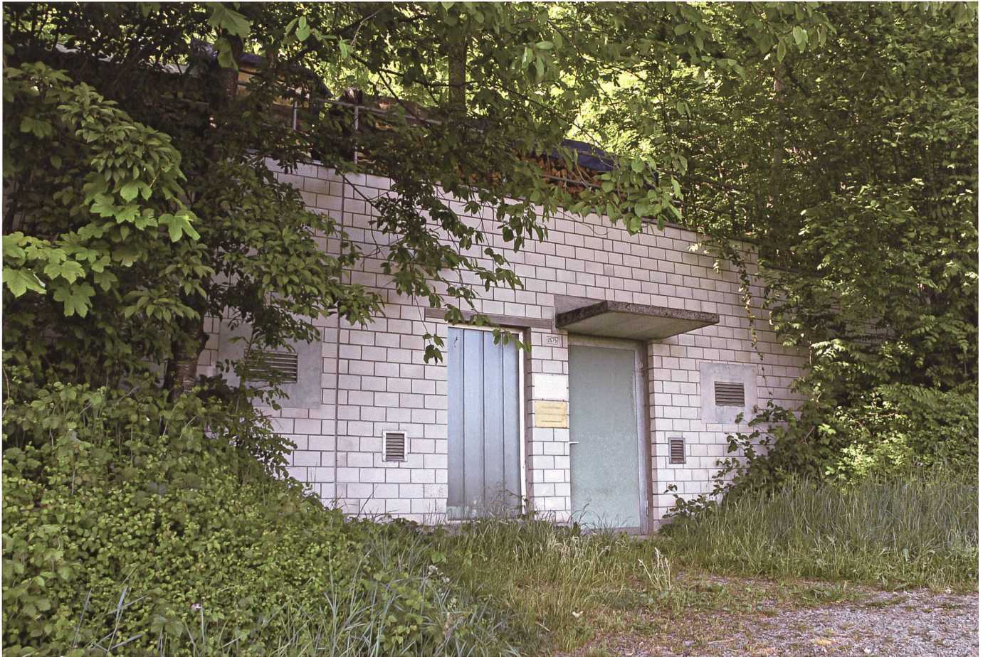
Im 1974/75 von der Dorfkorporation Sennwald gebauten Reservoir Strigg wurde auch die Betriebswarte untergebracht.
