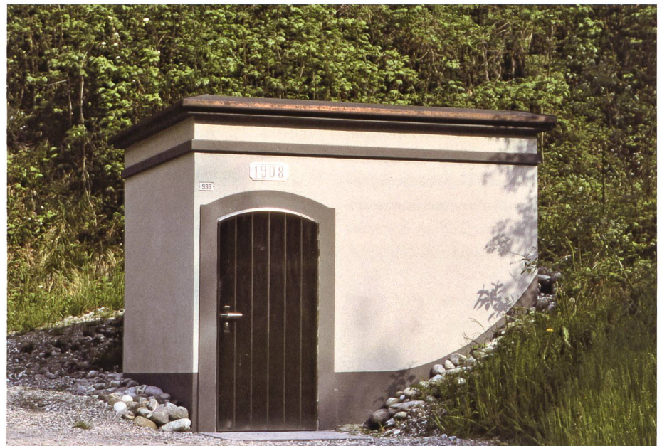
Das im Jahr 2010 nach mehr als hundert Jahren Betrieb stillgelegte Reservoir Löchli.
