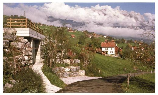
Von aussen ist nicht ersichtlich, dass das Reservoir Perdell (Ampadell) auf rund 530 m ü. M. mit 1300 m³ Trink- und Brauchwasser sowie 500 m³ Löschwasserreserve das grösste Reservoir der Grabser Wasserversorgung ist.
