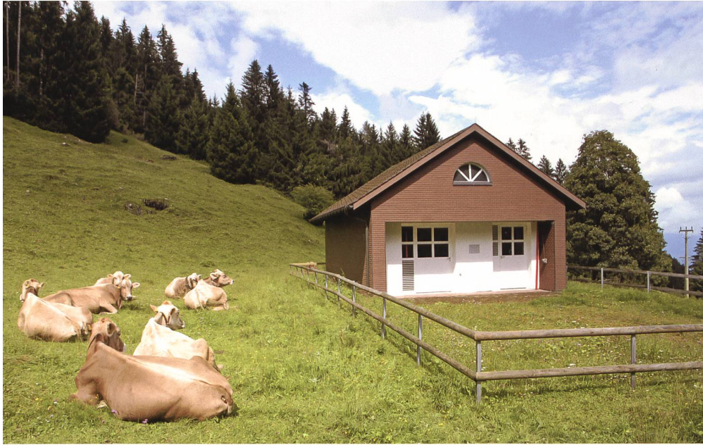
Die Anlage Höhi mit 500 Kubikmeter fassendem Reservoir (je 250 m 3 Brauchwasser und Löschwasserreserve), einer UV-Aufbereitungsanlage sowie in der linken Gebäudehälfte einer Turbine mit Generator zur Stromerzeugung. Foto 2014 Hans Jakob Reich, Salez
