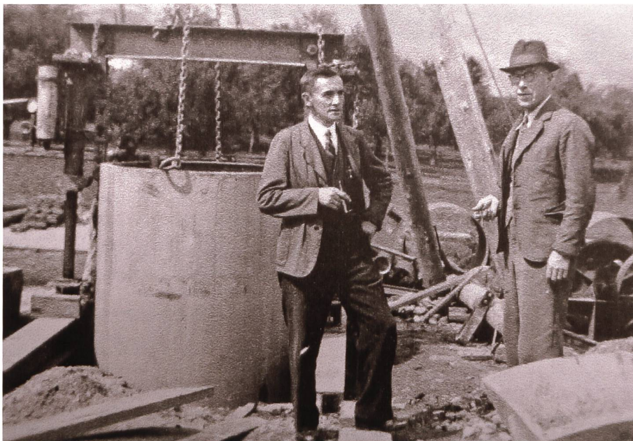
Bau des Grundwasserpumpwerks Schäfli am Studner Bach. Archiv TBG/WVG
