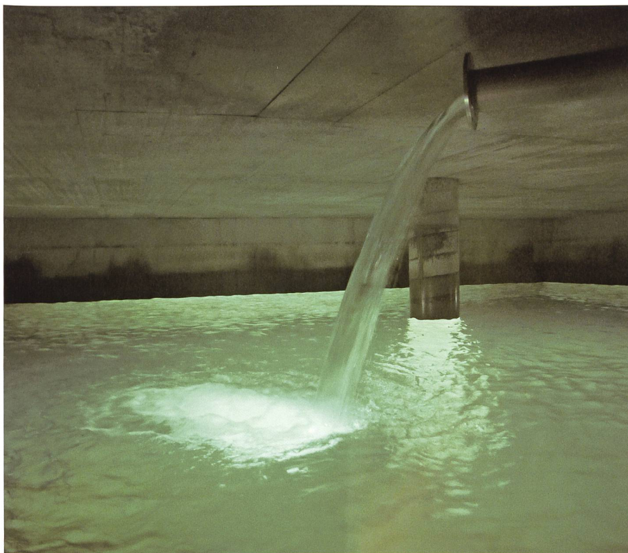
Gereinigt fließt das Wasser auf Grist in die beiden Reservoirs mit je 675 m 3 Speicherkapazität. Foto 2014 Hans Jakob Reich, Salez
