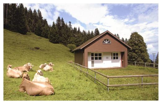
Die Anlage Höhi mit 500 Kubikmeter fassendem Reservoir (je 250 m³ Brauchwasser und Löschwasserreserve), einer UV-Aufbereitungsanlage sowie in der linken Gebäudehälfte einer Turbine mit Generator zur Stromerzeugung. Foto 2014 Hans Jakob Reich, Salez
