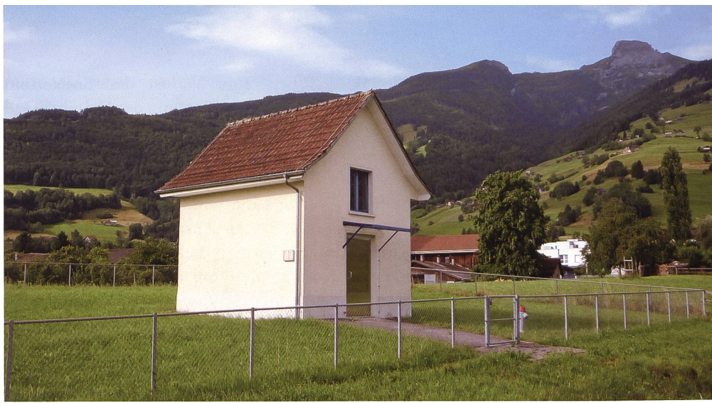
Grundwasserpumpwerk am Studner Bach, im Hintergrund der Margelchopf und der Studner Berg. Foto 2014 Stefan Egli, Luzern/Oberschan
