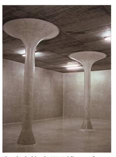
Eine der beiden je 900 Kubikmeter fassenden Kammern des Talzonenreservoirs Perdell (Ampadell) in leerem Zustand.
