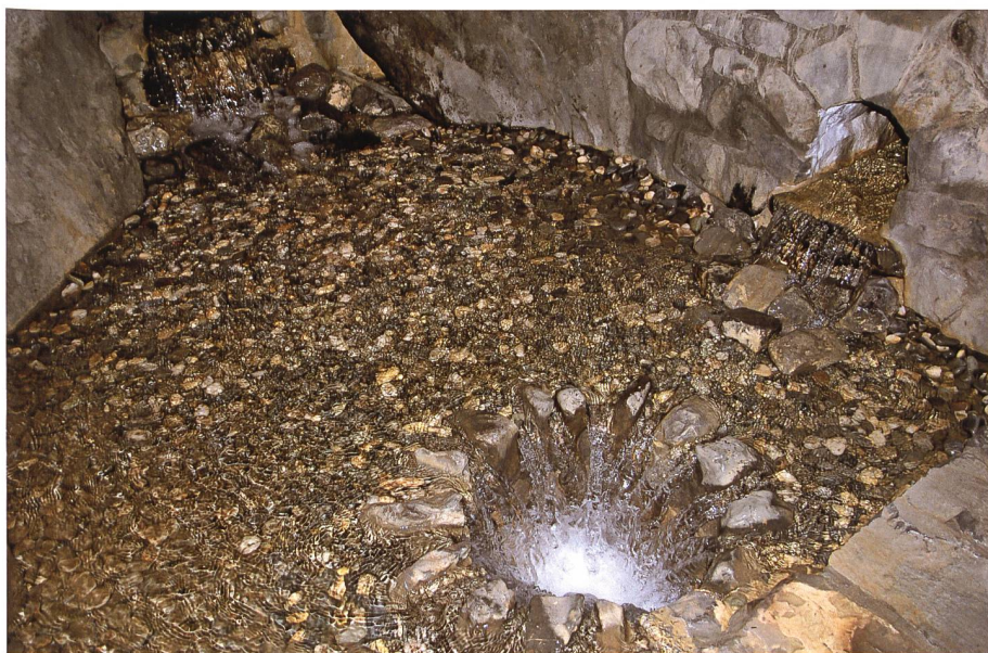
In die Sammelstube Albrechtsbrunnen fliesst das Wasser aus einer frontal gefassten Hauptquelle (oben links) und einer seitlichen kleineren Quelle ein. Foto 2014 Hans Jakob Reich, Salez
