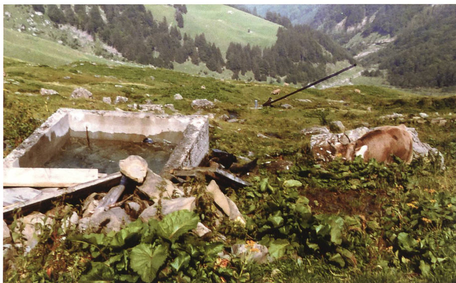
Blick von der Brunnenstube der Widderquelle zur Widderanlage (Pfeil) anno 1981.
