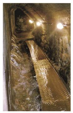
In der Quellfassung Fermärsch tritt das Wasser in zwei horizontalen Spalten aus dem Fels. Foto EW Azmoos
