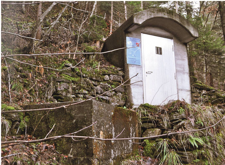
Quellfassung Fermärsch samt Überlaufschacht und Informationstafel mit Quellschema.
