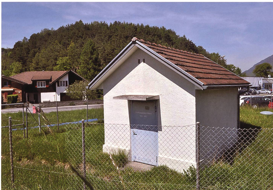
Im Pumpenhaus bei der Lonna arbeiteten ab 1951 zwei Pumpen, ab 1989 waren es deren drei, die das Grundwasser zum Reservoir Girangga/Ferschlinis hinaufpumpten; heute dienen noch zwei allein als Löschreserve.
