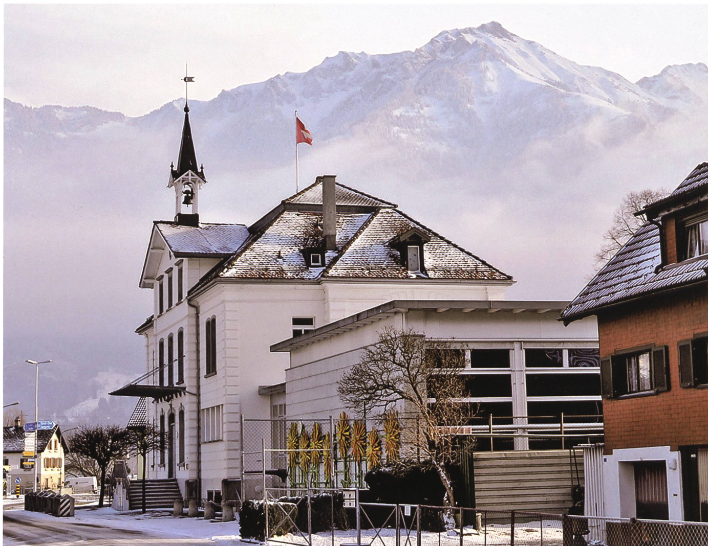
Auch der Unterhalt von Türmli und Glocke auf dem Schulhausdach gehören heute zu den erweiterten Aufgaben der Dorfkorporation Weite.
