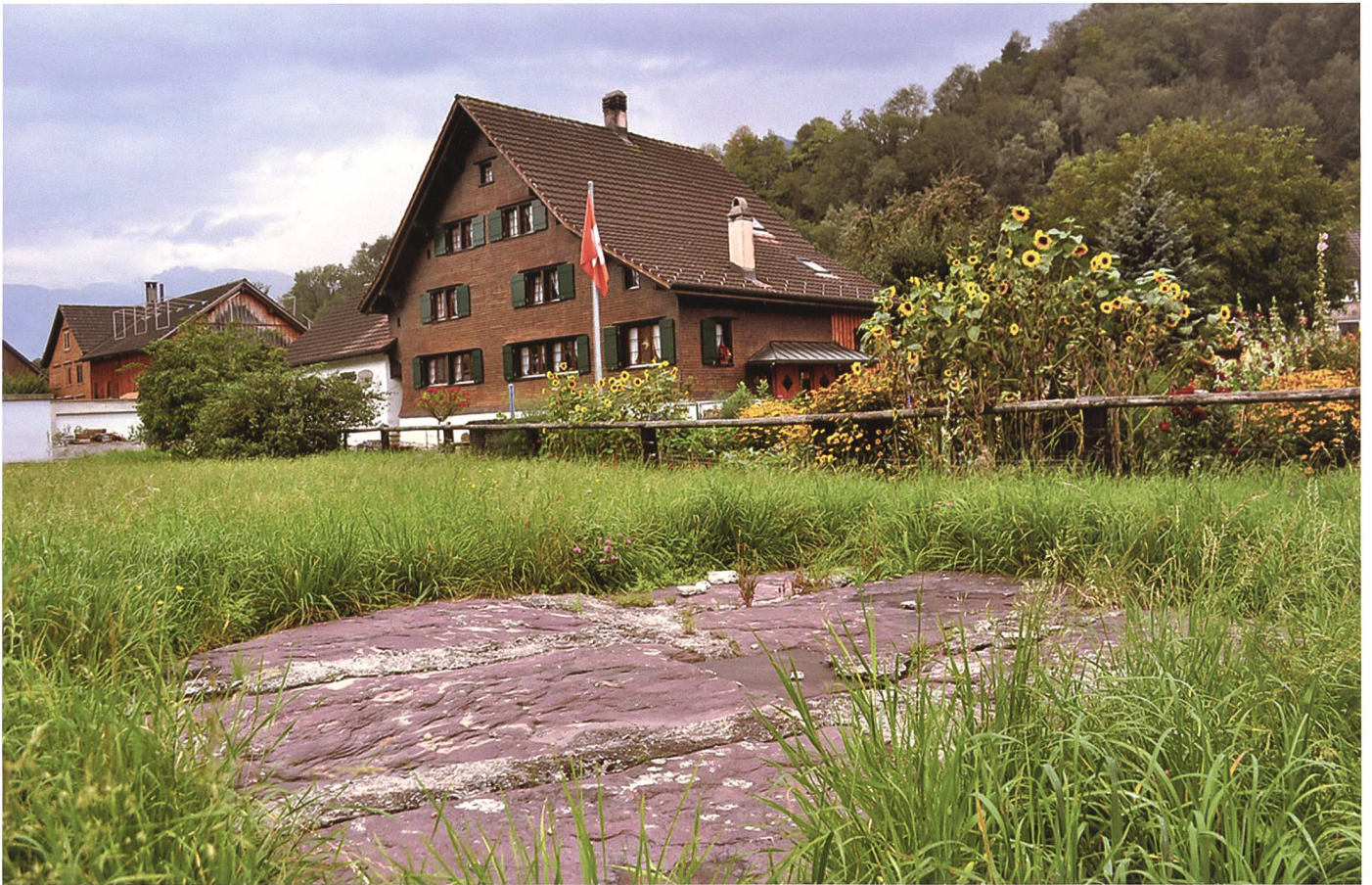
In den ehemaligen Feuerwehrweiher in der Hinderwiti – überdeckt wie viele seiner Art mit Verrucanoplatten aus dem Steinbruch Tiergarten bei Mels – ergoss sich einst wahrscheinlich das Abwasser des laufenden Brunnens in der Hinderwiti.
