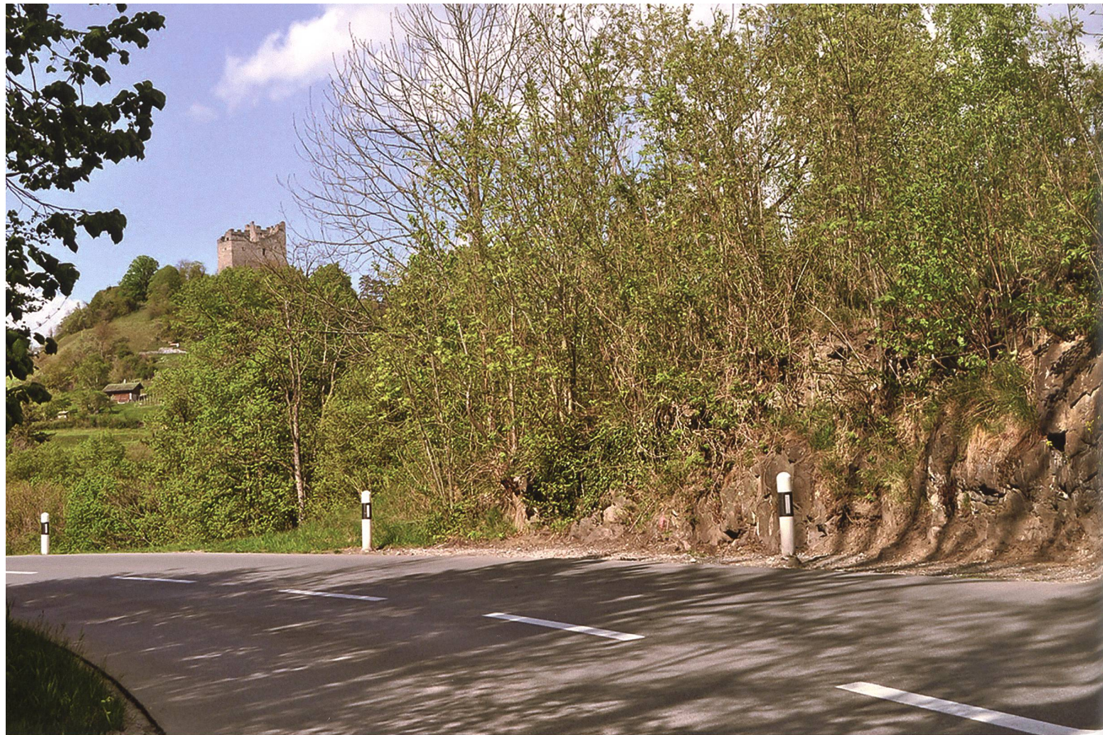
Das Reservoir der Dorfkorporation Weite rechterhand der Strasse Fontnas-Gretschins bei Girangga/Ferschlinis wurde teilweise in den Fels gebaut.
