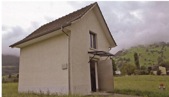
Ein typischer Vertreter der um die Mitte des 20. Jahrhunderts gebauten Grundwasserpumpwerke: das Pumpenhaus der Wasserversorgung Grabs am Studner Bach.
