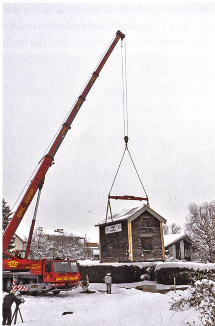
21. Dezember 2011: Der Kran hebt die acht Tonnen schwere Messerschmiede an.
