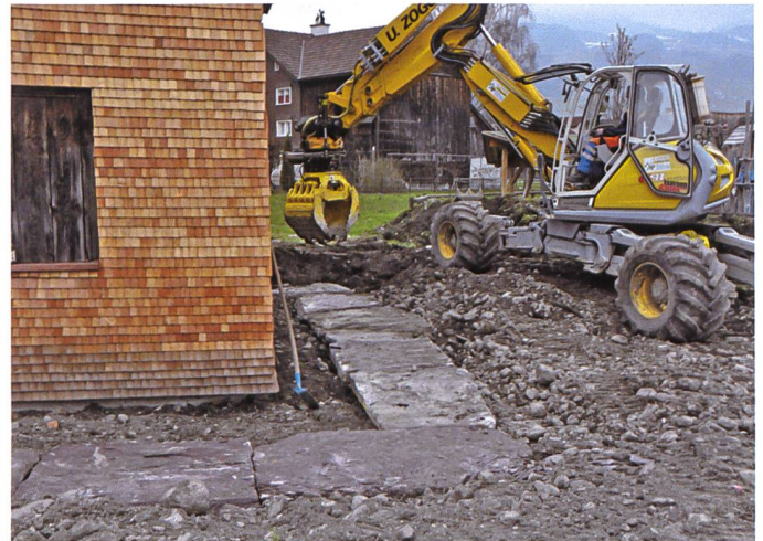
3. April 2013: Bei den Umgebungsarbeiten werden alte Melser- oder Verrucanoplaten für den Fussweg verlegt.
