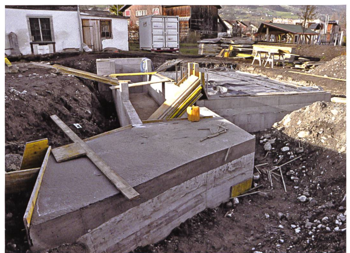
2. Dezember 2011: Der neue Kanal und das Fundament für die Messerschmitte stehen bereit.
