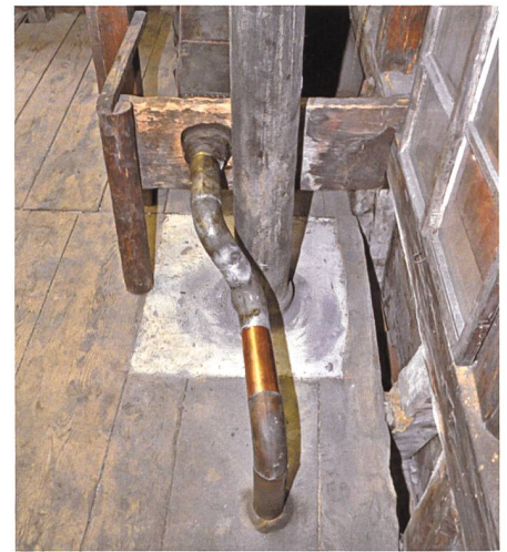
13. August 2013: Hier kreuzen sich der Kamin der Esse und die Luftabfuhr aus dem Blasebalg.
