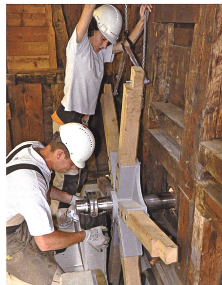
11. Juli 2012: Simon und Petra Oehrli montieren knapp neben dem Kammrad die Welle auf dem Auflager.
