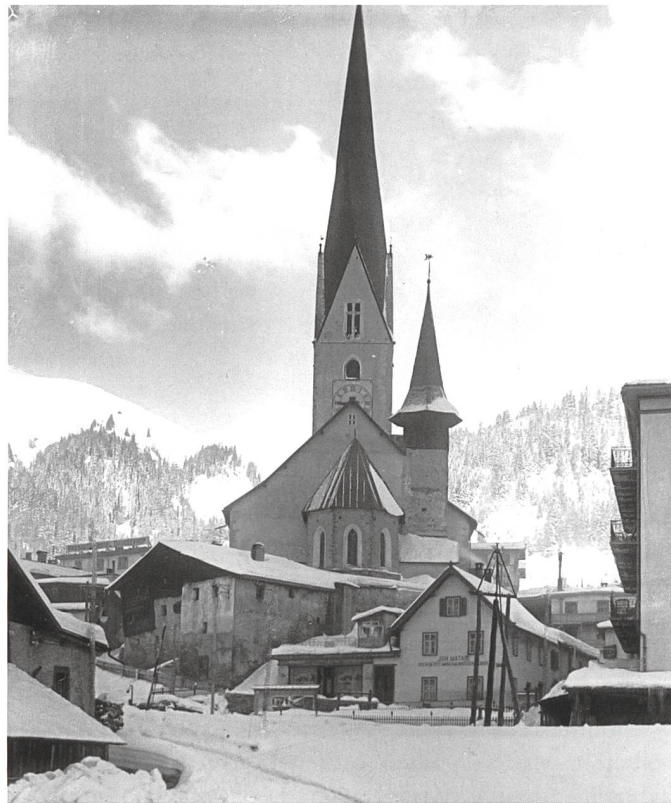
Die Davoser Hauptkirche am Platz wurde wohl um 1289 gegründet. Vom ersten Bau sind noch die unteren Teile des kleinen Turms vorhanden. Der grosse Turm, 1481 errichtet, zeigt in seinen Dimensionen die Bedeutung der privilegierten Walsergemeinde. Foto Christian Meisser, 1911.
