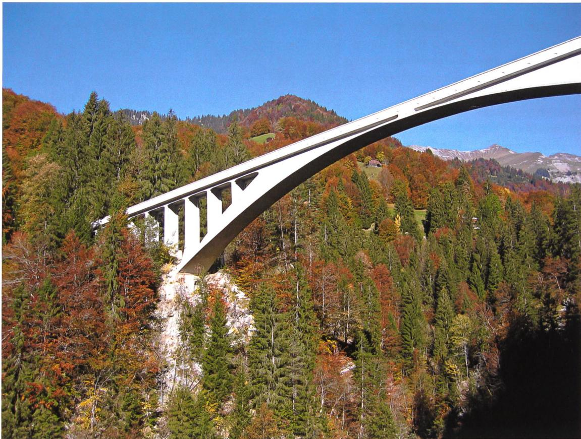
Die Salginatobelbrücke zwischen Schiers und Schuders. Sie ist 132 Meter lang, weist eine grösste Spannweite von 90 Metern und eine lichte Höhe über dem Tobel von 93 Metern auf.
