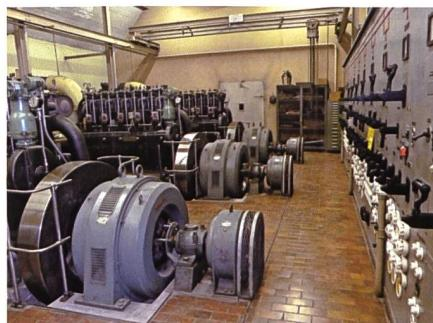
**Für die Notstromversorgung dienten Sulzer-Schiffsdieselmotoren mit 200 PS Leistung, Baujahr 1941. Zwei der drei Motoren-/Generatorengruppen dienten für den Notbetrieb, die dritte war Reserve. Rechts das Stromverteilungstableau. Für die Wartung der Einrichtungen hatte das Werk eine eigene Werkstatt mit Ersatzteillager.**
