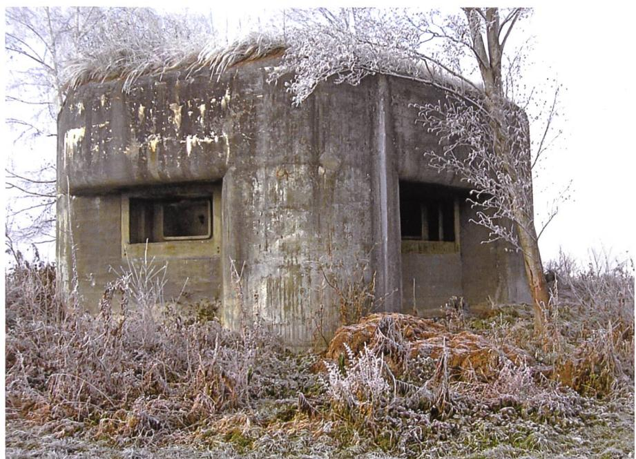
Maschinengewehrbunker Sarganserau 3 der Bunkerlinie 3. Die Schussrichtung aus der Scharte links geht gegen Bunker Sarganserau 1, aus der Scharte rechts gegen Sarganserau 2. Abgesehen von der abgewinkelten Bauweise waren sie gleich gebaut wie jene der Linie 2.
