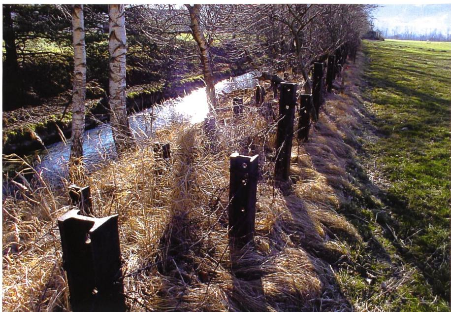
**Mit eingerammten Eisenbahnschienen verstärktes Panzerhindernis am Saarkanal. Im Hintergrund ein Bunker der Linie 2. Die Stacheldrahtbahnen sind hier bereits abgebaut.**
