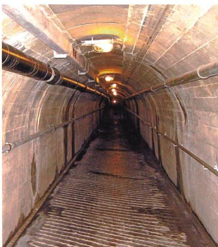
Der Schrägstollen zur oberen Etage überwindet auf 150 Meter Länge einen Höhenunterschied von 30 Metern. Am oberen Ende befindet sich ein Innenverteidigungsstand.
