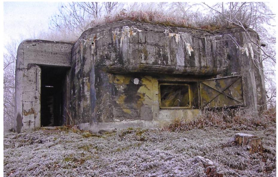
**Bunker Sarganserau 2.** Der Baugrund wurde aus Hochwasserschutzgründen erhöht. Der Blick von Norden zeigt den geschützten Eingangsbereich, die Maschinengewehrscharte mit offener Tarnung und – der helle Punkt links der Scharte – das Ende des ehemaligen Handgranatenauswurfkanals. Die Betonbacke rechts schützt gegen die Front (Saarseite) vor Kurzdistanzbeschuss.
