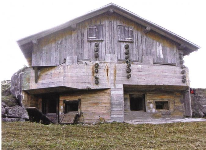
**Der Bunker auf Boden-Kuppe mit offenen Tarntoren. Unten die Maschinengewehr- und Beobachterscharten, oben die Unterkunft für den Nichtgefechtsfall; die Gefechtsunterkunft befindet sich im unterirdischen Untergeschoss. Im Bild rechts die Anlage von hinten mit dem Eingang zur oberen Unterkunft.**
