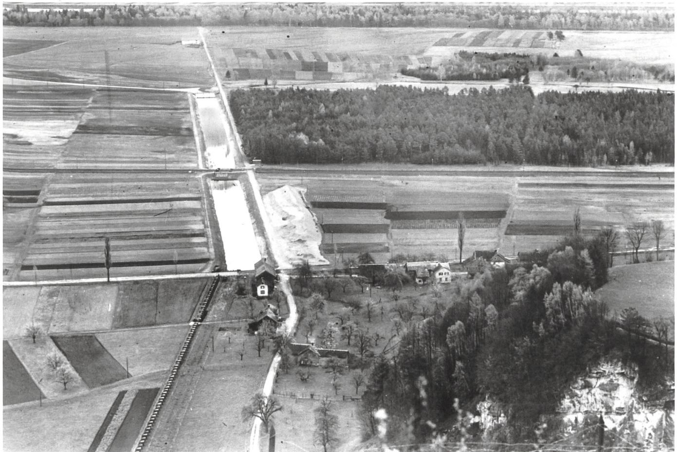
**Die Baustelle Plattis, vermutlich 1940. Im Vordergrund die Höckersperre, in der Bildmitte links die Tankgräben 1 und 2, an deren Ende der verlegte Mülbach als Graben 3. Der ausgehobene Kies (Deponie rechts beim Tankgraben 1) wurde der Baustelle Festung Magletsch zugeführt.**
