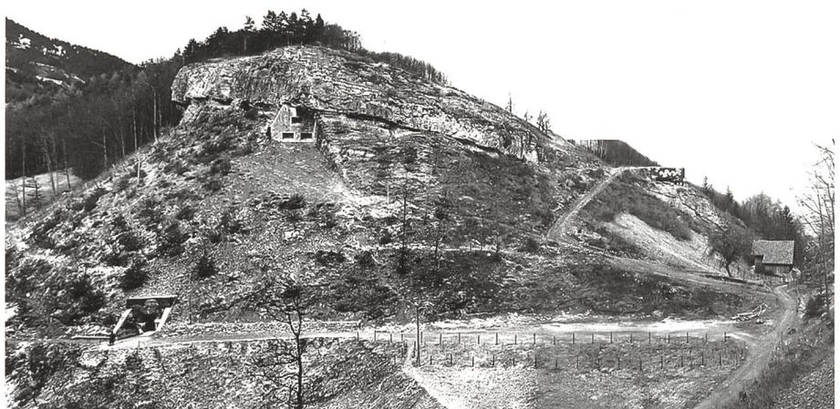
**Die Maschinengewehrstände am Brögstein während des Baus. Unten links der Eingang, rechts darüber die beiden Mg-Stände West mit dem Beobachterstand. Die Mg-Stände Ost befinden sich über dem Stall rechts. Schutzfeuer war für Brögstein von Magletsch aus den Mg-Ständen 7 und 8 möglich.**
