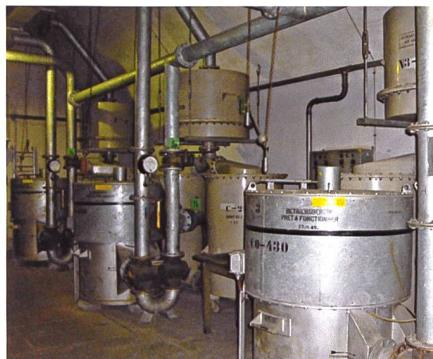
**Filteranlagen zur Reinigung der Umluft für den kollektiven Maskenschutz mit einer Umwälzkapazität von 15 000 m<sup>3</sup> pro Stunde.**
