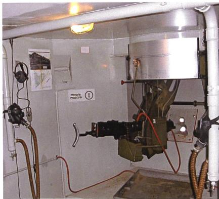
**Maschinengewehrstand 8 mit zurückgezogenem Festungsmaschinengewehr 11. Die Scharte ist geöffnet; das untere Loch ist für den Waffenlauf, das obere für das Zielfernrohr. Vorne oben links der Wassertank für die Laufkühlung. Beidseits sind Atemschutzmasken angebracht mit Luft aus der zentralen Werkfilteranlage.**
