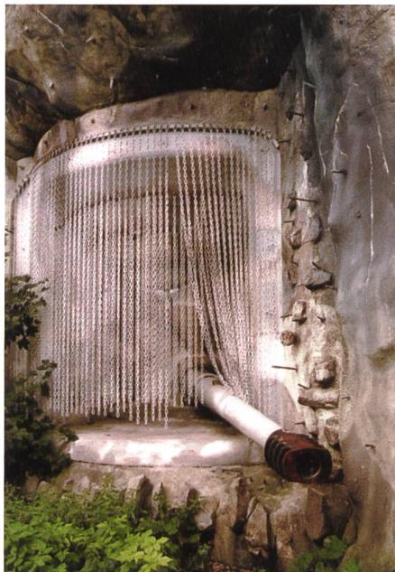
**Scharte mit Kettenschutzvorhang des erweiterten Artilleriewerks Furggels: das Rohr ist ausgefahren und schussbereit.**
