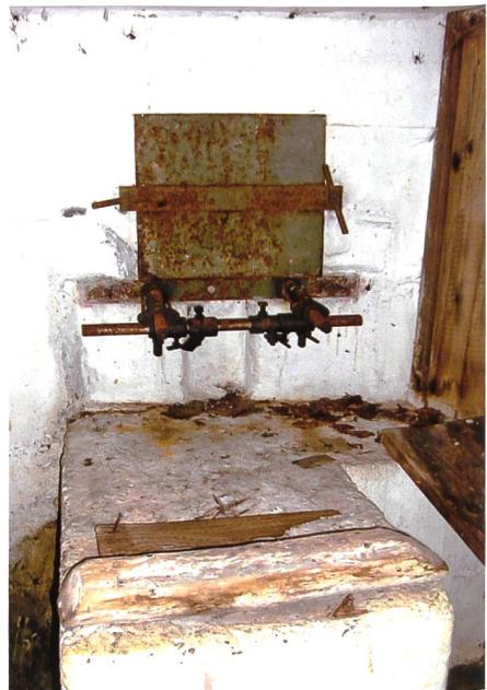
Die geschlossene Scharte von innen mit der vom Dorfschmied gefertigten Konstruktion für die Maschinengewehrhalterung.
