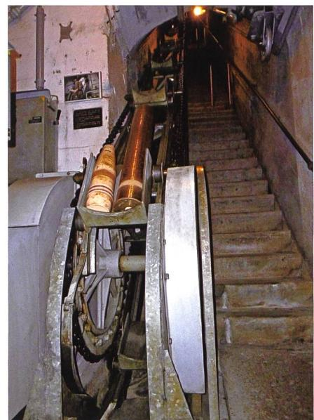
**Treppe zu einem Panzerturm mit Munitionstransportanlage (Paternoster) mit einer Granate (links) und rechts einer Hülse für die Triebladung.**
