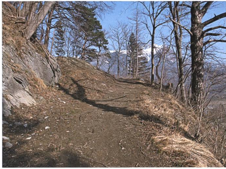
Abb. 10: Kurz vor der Kuppe nach dem steilsten Strassenstück. Die Ausweichstelle ist zur Hälfte von einem Schuttkegel überdeckt. Foto Maja Widmer, Sargans
