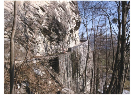
Abb. 7: Eine hohe Mauer stützt das Strassentrassee entlang der grossen Hohwand.
