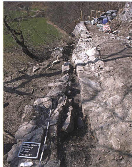
Abb. 20: Die nachträgliche Verbreiterung der Brüstungsmauer. Im Hintergrund verschwindet die Schollbergstrasse Richtung Hohwand und Sargans.
