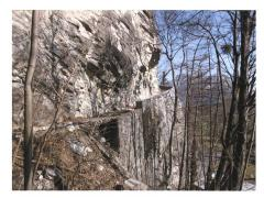
Abb. 7: Eine hohe Mauer stützt das Strassentrassee entlang der grossen Hohwand. Foto Maja Widmer, Sargans
