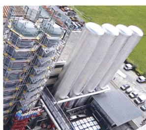
Um Versorgungsgapse auszuschliessen, hat die KVA eine saubere Lösung entwickelt. Den Verantwortlichen war von Anfang an klar: zusätzlich Erdöl zu verbrennen ist keine Option. Ins Zentrum der Überlegungen rückte die Idee, bei akutem Anstieg des Warmwasserverbrauchs auf Heisswasserspeicher zurückgreifen zu können. Die Berechnungen zeigten, dass mit überdimensionalen Boilern – die je 200 000 Liter fassen – 150°C-heisses Wasser gelagert werden kann. Dieses wird bei übermässigem
