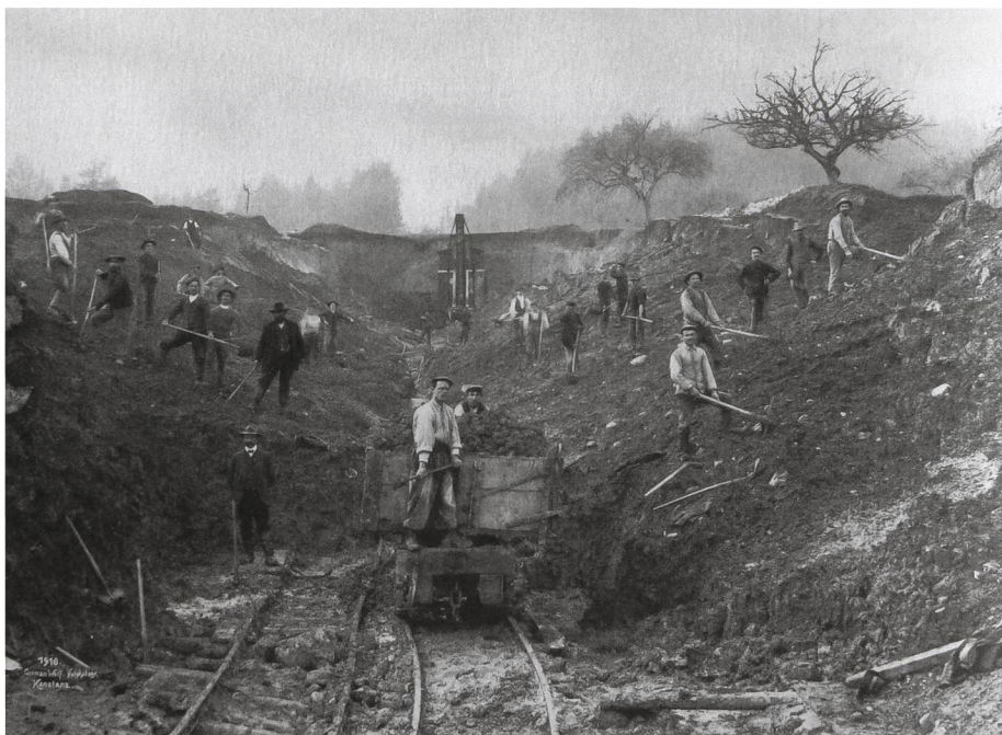
Bei den Arbeiten am Trasse der Bodensee-Toggenburg-Bahn standen 1908 bereits erste technische Hilfsmittel zur Verfügung, während der Bau der Rheintalbahn 1856/57 noch weitestgehend in reiner Handarbeit erfolgte. Aus Menolfi 2003, S. 122
