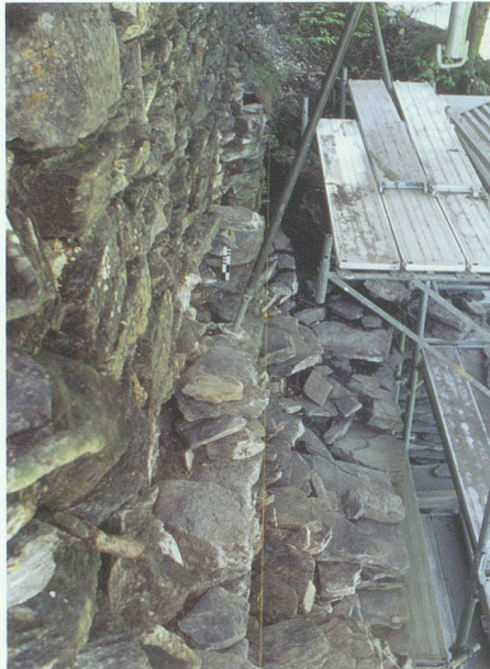
Abb. 32: Turm, Mauer M2. Freigelegte Mauerabsätze auf der Mauerinnenseite oberhalb des Hocheingangs, von ENE.
