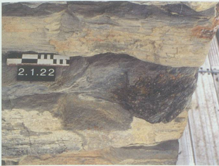
Abb. 43: Turm, Mauerecke M1/M2. Nachträglich in zwei Ecksteine eingehauene Konsole 2.1.22, von SSW.
