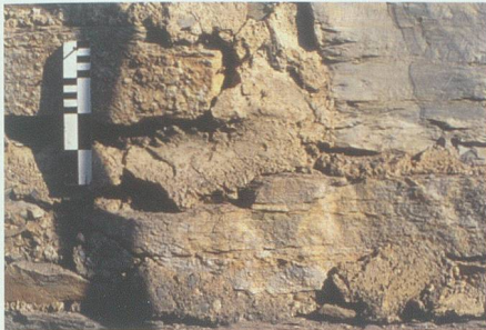
Abb. 14: Turm, Mauer M2. Bauzeitliche Putzreste mit Abdruck einer Mauerkelle (Kote 759.80), von SSE.
