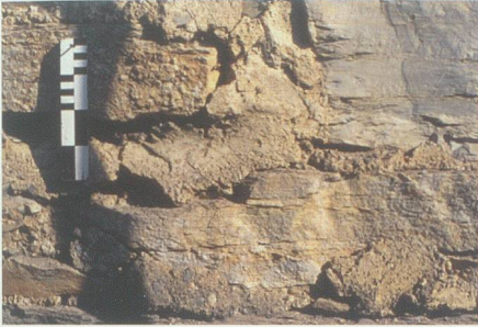
Abb. 14: Turm, Mauer M2. Bauzeitliche Putzreste mit Abdruck einer Maurerkelle (Kote 759.80), von SSE.
