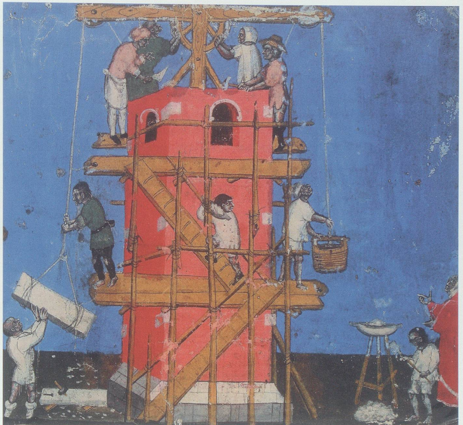
Abb. 53: Spätmittelalterliche Darstellung einer Baustelle mit einem Kran und einem Stangengerüst mit Laufschräge. Rudolf von Ems, Weltchronik, 1385
