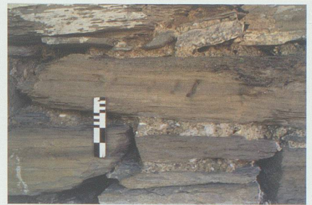
Abb. 13: Turm, Mauer M3. Steinmetzzeichen (Kote 761.00), von WSW.
