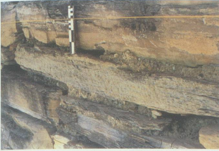
Abb. 11: Turm, Mauer M2. Mit Zweispitz- oder Spitzeisen bearbeitete Steinoberfläche (Kote 761.60), von ESE.
