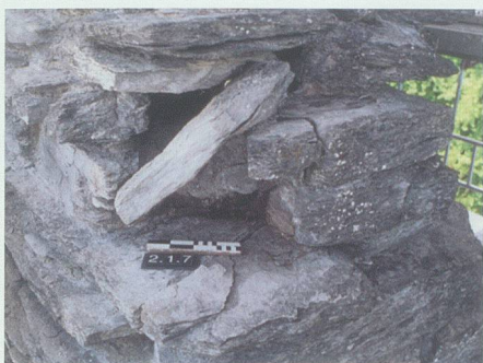
Abb. 44: Turm, Ecke M1/M2. Das Balkenloch des über Eck auskragenden Balkens 2.1.7. Es gehört zur Laube, die bei der Reparatur des Turms eingebaut wurde, von SE. Der schräg liegende Stein bildete ehemals den äusseren, oberen Abschluss des Balkenlochs.
