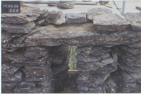
Abb. 37: Turm, Mauer M2. Nachträglich eingesetzter Mauerkeil in der lichten Öffnung des Fensters 2.9, von NNW.
