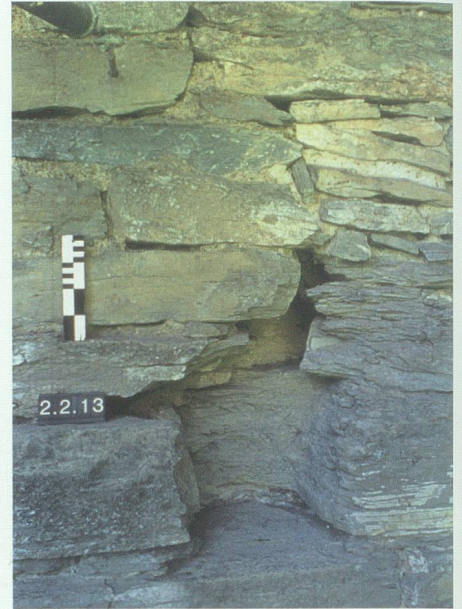
Abb. 33: Turm, Mauer M2. Die mit dem Balkenloch 2.2.13 ausgehauene Erweiterung nach rechts oben wurde nach dem Einlegen des Balkens zugemauert, von N.
