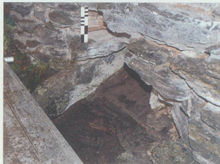
Abb. 49: Schildmauer. Mündung eines Abwasserkanals, der unter der Mauer hindurch ins Freie führte, von SSW.
