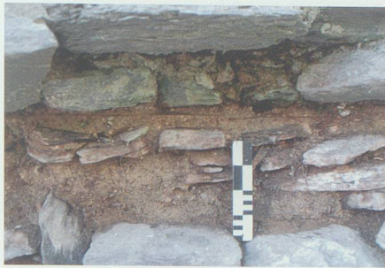
Abb. 35: Turm, Mauer M2. Horizontale Fuge im Kernmauerwerk des zweiten Obergeschosses, von NNW. Sie trennt zwei deutliche Bauabschnitte.
