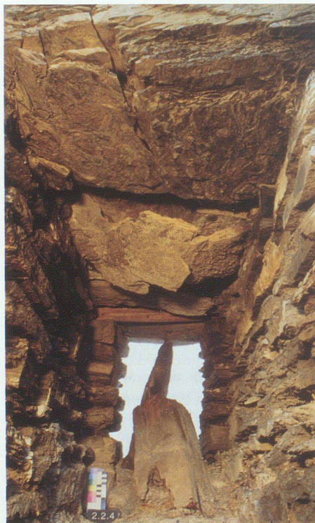
Abb. 31: Turm, Mauer M2. Blick auf den Sturz des Fensters 2.2.4. Im Hintergrund ist ein Balkenrest zu sehen, der unter nicht bekannten Umständen in der Öffnung deponiert worden war und im Laufe der Zeit von einer Schicht aus herabgerieseltem Mörtelsand bedeckt wurde, von NNW.
