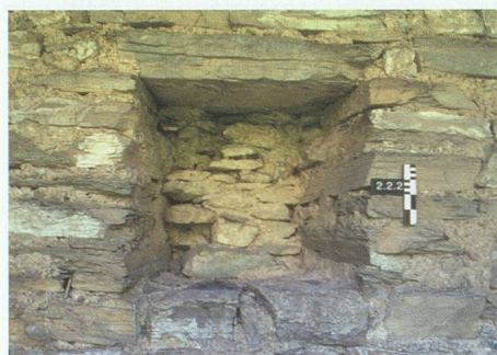
Abb. 24: Turm, Mauer M2. Innenansicht des nachträglich zugemauerten Fensters 2.2.2, von NNW.
