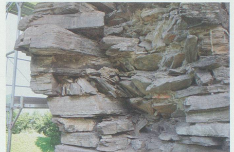
Abb. 16: Turm, Mauer M1. Locker verfüllter Mauerkern in der Abrisskante, von NW.
