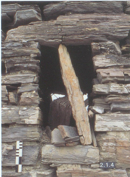
Abb. 30: Turm, Mauer M2. Aussenansicht des Fensters 2.1.4 mit geborstenem und mit einer hochkant gestellten Steinplatte abgestütztem Sturz, von SSE.
