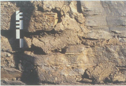
Abb. 14: Turm, Mauer M2. Bauzeitliche Putzreste mit Abdruck einer Maurerkelle (Kote 759.80), von SSE.
