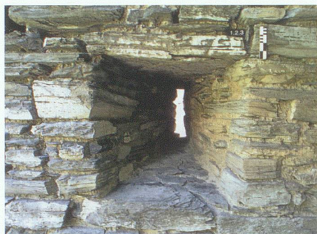
Abb. 23: Turm, Mauer M1. Fenster 1.3, Innenansicht, von WSW.
