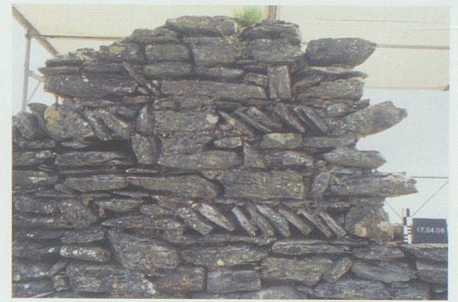
Abb. 36: Turm, Mauer M2. Lagen mit Ährenverband im nachträglich aufgesetzten Mauerwerk auf der Innenseite des zweiten Obergeschosses, von NNW.
