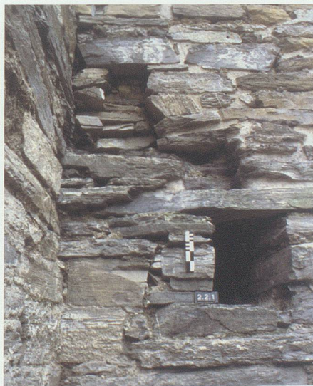
Abb. 22: Turm, Mauer M2. Mündung des Lüftungskanals 2.2.1 und Balkenloch 2.2.11 auf der Mauerinnenseite, von NNW.
