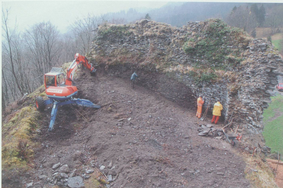
Abb. 47: Schildmauer. Ein Teil des Mauerschuttkegels auf der Rückseite der Mauer wird mit dem Schreitbagger abgetragen.
