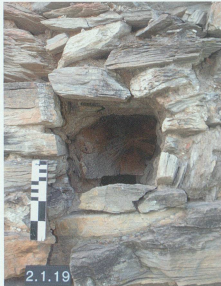
Abb. 40: Turm, Mauer M2. Im Zuge der Reparatur der Zugangslaube eingesetzter, stirnseitig angekohlter eichener Balkenrest im Balkenloch 2.1.19, von SSE.
