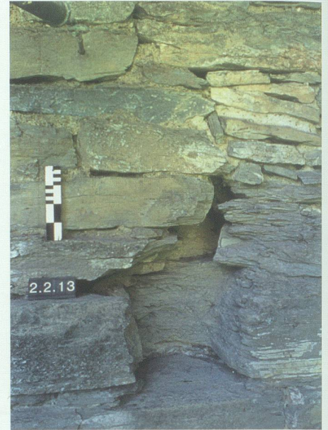
Abb. 33: Turm, Mauer M2. Die mit dem Balkenloch 2.2.13 ausgehauene Erweiterung nach rechts oben wurde nach dem Einlegen des Balkens zugemauert, von N.
