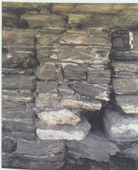
Abb. 21: Turm, Mauer M1. Zugemauerte, noch deutlich erkennbare Bau(?)-Öffnung am Mauerfuss, von ENE.
