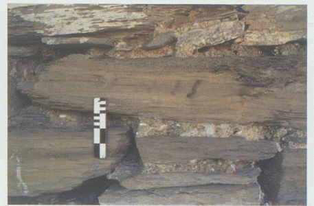
Abb. 13: Turm, Mauer M3. Steinmetzzeichen (Kote 761.00), von WSW.
