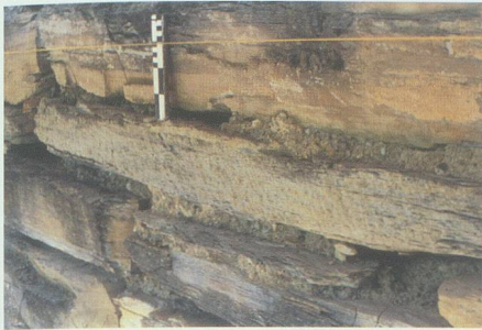
Abb. 11: Turm, Mauer M2. Mit Zweispitz oder Spitzisen bearbeitete Steinoberfläche (Kote 761.60), von ESE.
