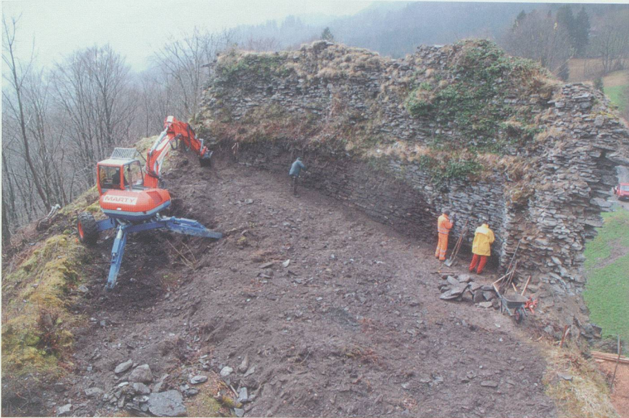
Abb. 47: Schildmauer. Ein Teil des Mauerstuttkiegels auf der Rückseite der Mauer wird mit dem Schreitbagger abgetragen.
