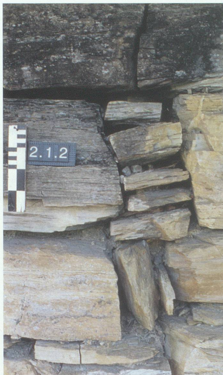
Abb. 25: Turm, Mauer M2. Aussenansicht des nachträglich zugemauerten Fensters 2.1.2, von SSE.
