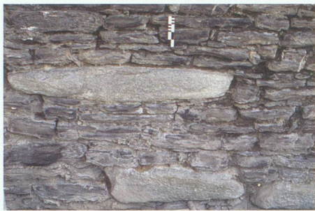
Abb. 46: Schildmauer. Findlinge aus Urgestein im äusseren Mauermantel, von W.
