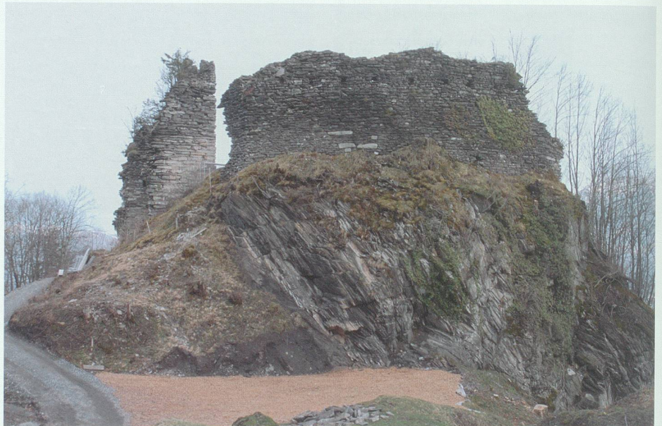
Abb. 1: Blick von Westen auf Schildmauer und Turm der Ruine Hohensax zu Beginn der Arbeiten am 15. März 2008. Foto Hans Jakob Reich, Salez
