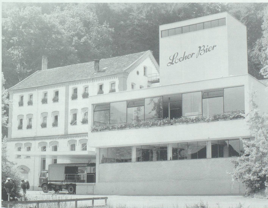
Die Gebäude der Brauerei Locher AG 1972 – ein Jahr vor dem Zusammengehen mit Calanda Bräu. Archiv Hansruedi Rohrer, Buchs
