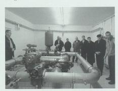
27. Oktober: Das neue Stufenpumpwerk Grabs-Buchs stellt den Austausch von Brauch- und Löschwasser sicher.
