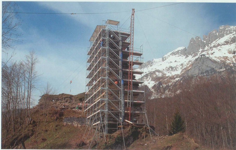
10. April 2008: Der Bergfried ist eingerüstet und die Kippmast-Krananlage erstellt.
