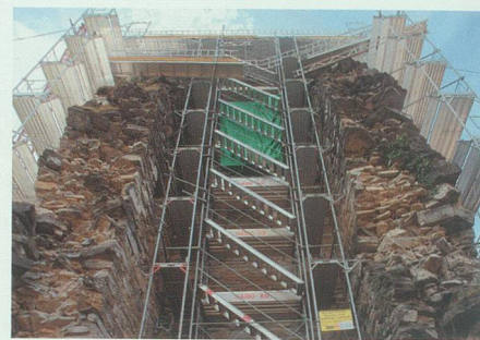
10. April 2008: Zur Stabilisierung des Baugerüsts haben sich die Gerüstbauer eine spezielle Konstruktion einfallen lassen.
