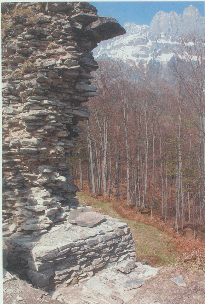
18. April 2008: Der Baumeister hat erste Ausfugungsarbeiten am Nordende der Schildmauer als Muster erstellt. Im Vordergrund unten eine freigelegte Fensteröffnung eines verschütteten Stockwerks.
