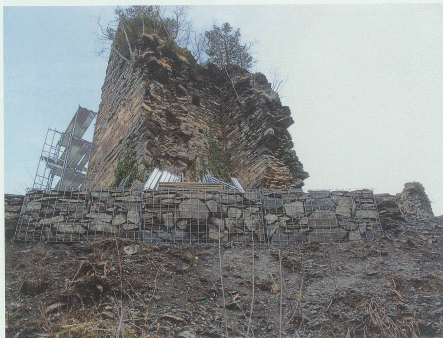
15. März 2008: Die Steinkörbe zur Sicherung des Burghofzugangs sind gesetzt und das Baugerüst ist im Bau.
