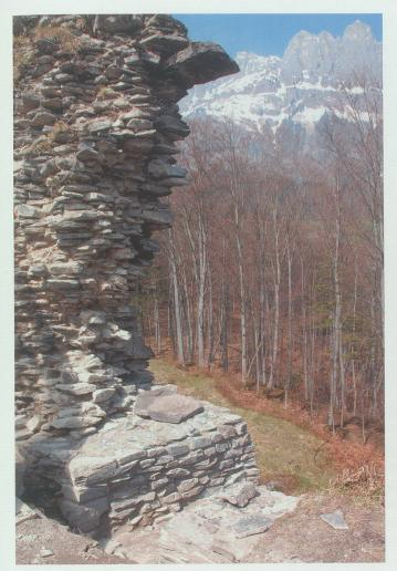
18. April 2008: Der Baumeister hat erste Ausfugungsarbeiten am Nordende der Schildmauer als Muster erstellt. Im Vordergrund unten eine freigelegte Fensteröffnung eines verschütteten Stockwerks.
