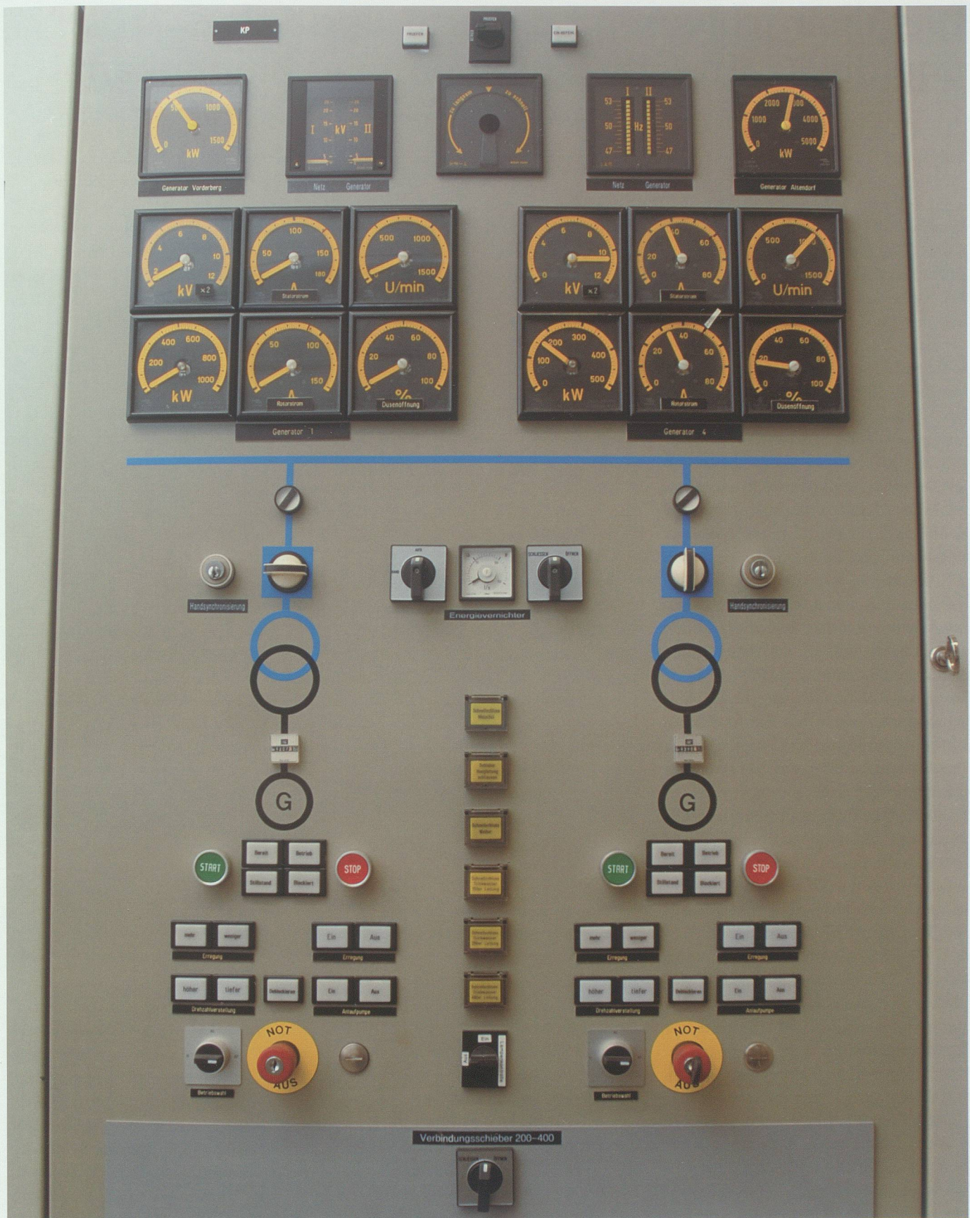
EWB-Maschinenhaus Tobelägerli/Buchs: Kommandotableau «Zählung/Registrierung».
