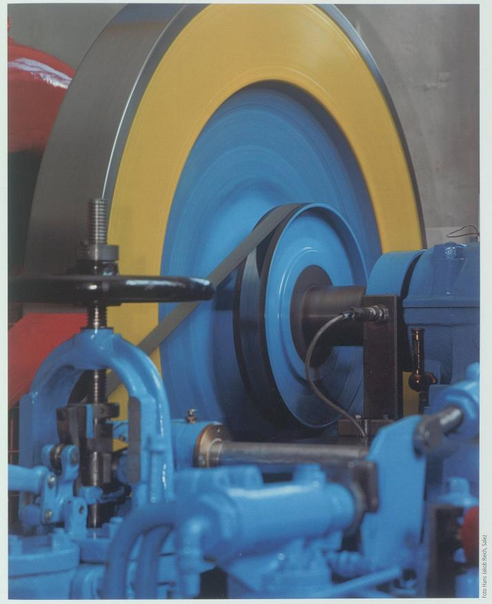
EWB-Maschinenhaus Tobeläggerli/Buchs: Turbine Jahrgang 1939 («s Vieri») mit 368 kW installierter Leistung.
