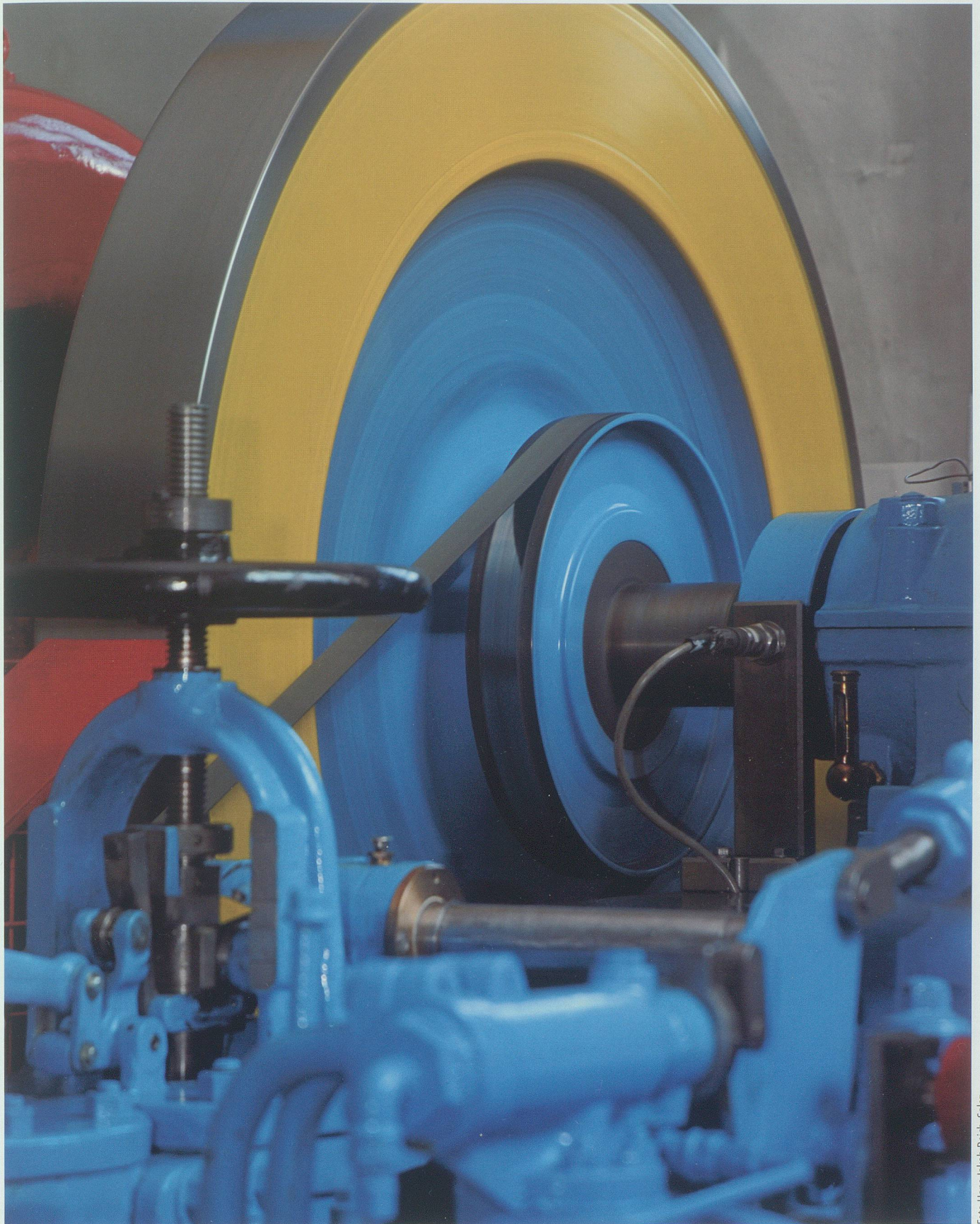
EWB-Maschinenhaus Tobelägerli/Buchs: Turbine Jahrgang 1939 («s Vieri») mit 368 kW installierter Leistung.
