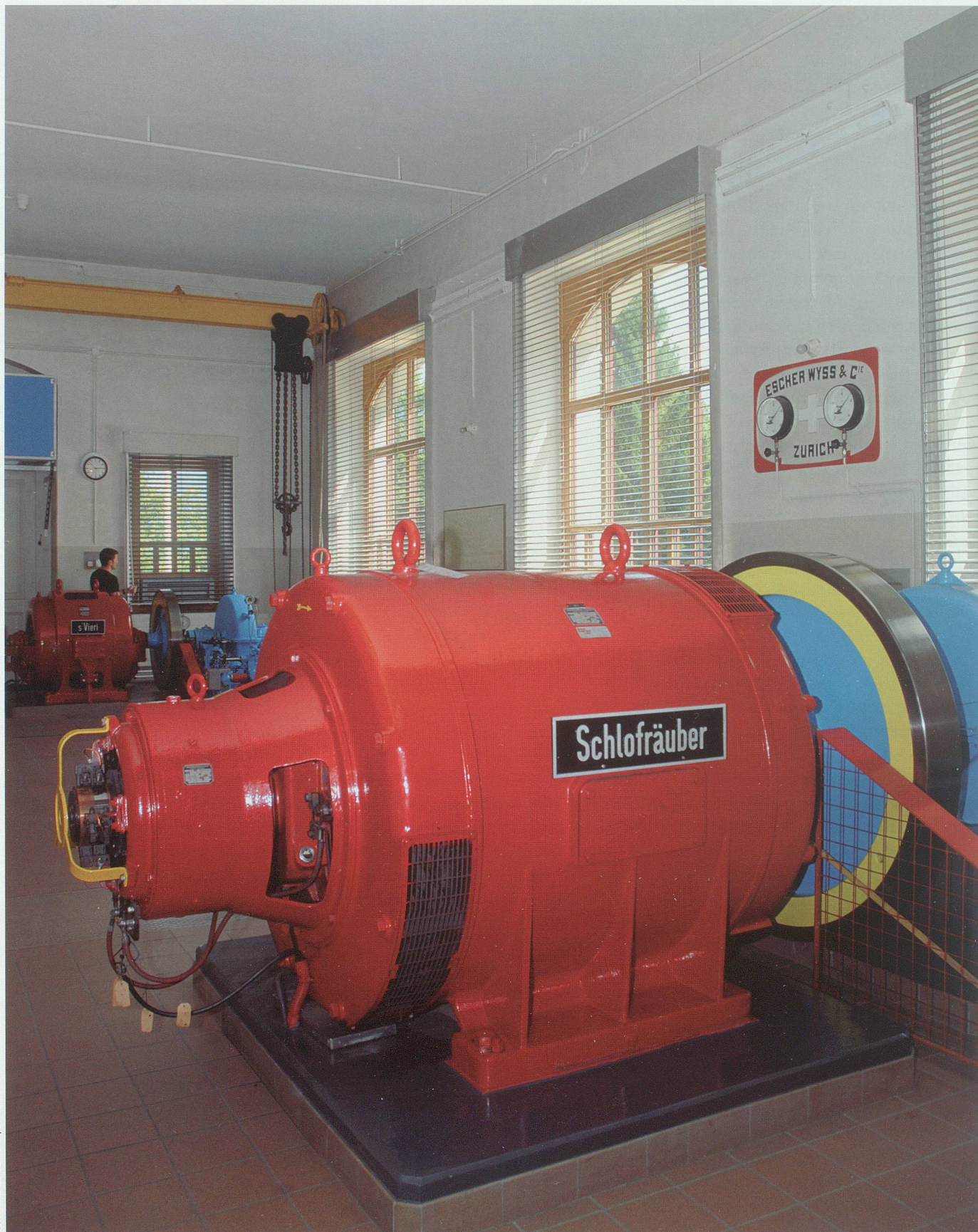
EWB-Maschinenhaus Tobeläggerli/Buchs: Turbine Jahrgang 1951 («Schlofräuber») mit 736 kW installierter Leistung.
