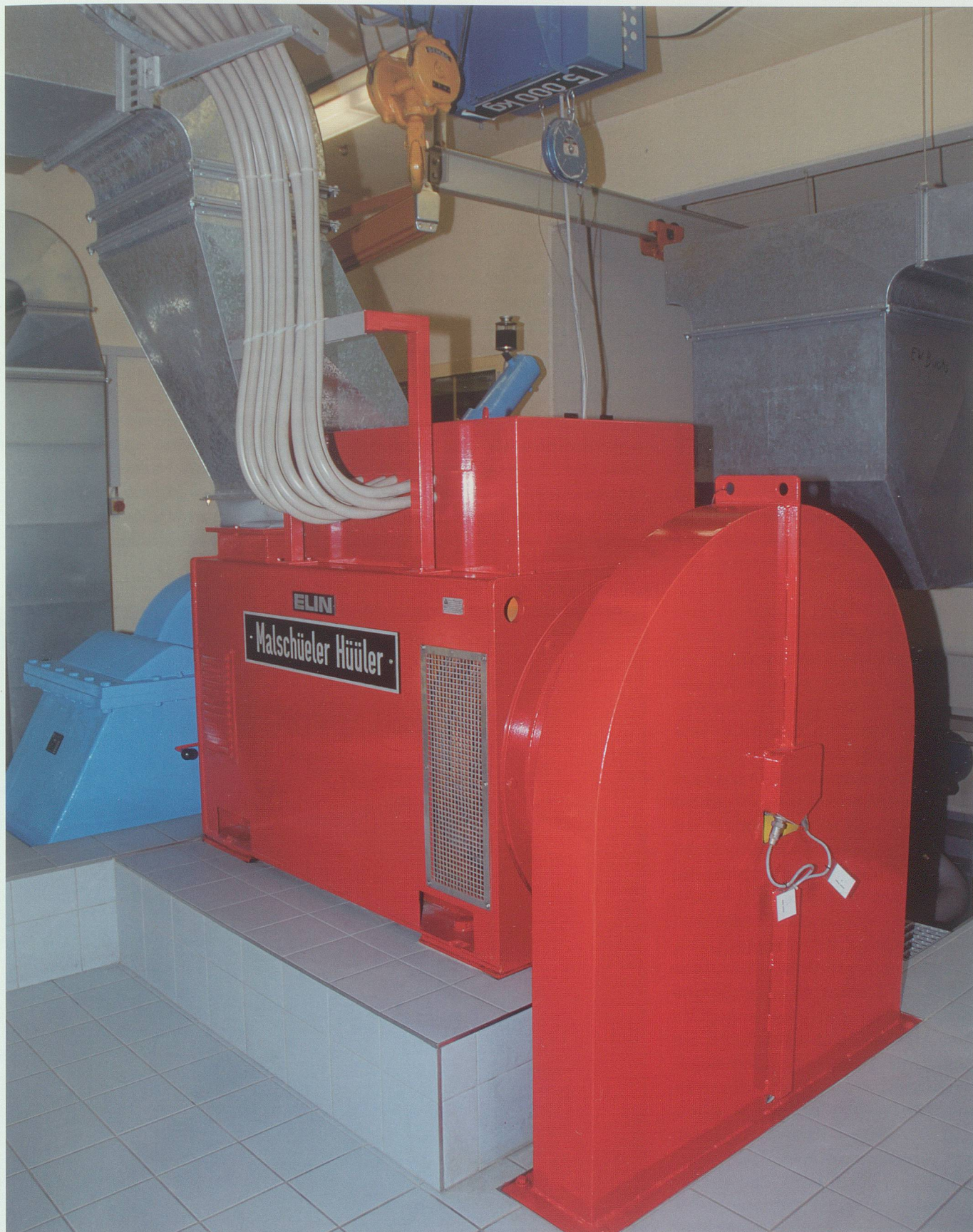
EWB-Kraftwerk Vorderberg/Buchs: 1000-kW-Synchrongenerator «Malschüeler Hüller».
