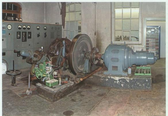
Die Maschinengruppe im Tobel liefert heute rund 18 Prozent des Strombedarfs des Dorfs. Die **Turbine stammt aus** dem Jahr 1941. Die noch mit Stoff isolierten Drähte des **Generators mussten** im Jahr 2000 nach einem Spannungsüberschlag ersetzt und neu gewickelt werden. Foto Tobias Hanselmann, Oberschan
