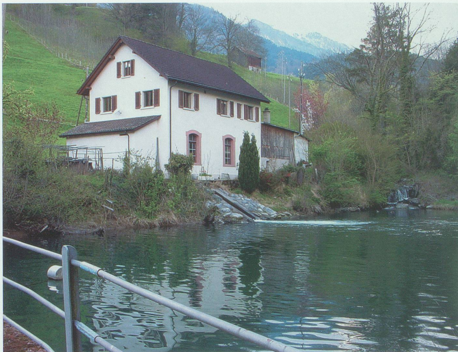
Das Maschinenhaus im Tobel: Das von den Turbinen austretende Wasser füllt gemeinsam mit dem Restwasser des Mülbachs den daneben liegenden Weiher für die Elektrizitätsversorgung der ehemaligen Weberei Azmoos. Die Freileitung führt über Pradarossa zum Dorf Oberschan. Foto Hansjakob Hanselmann, Oberschan
