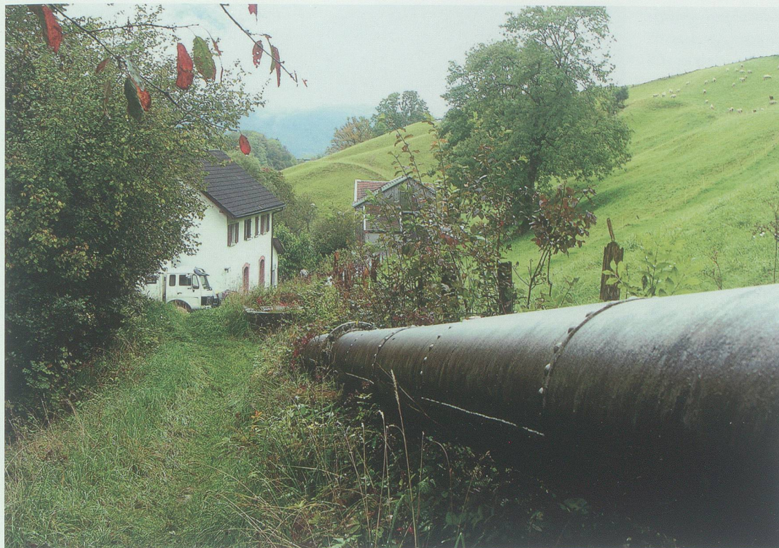
Die teils eingedeckte, teils offen liegende Druckleitung (Durchmesser 40 cm, Länge 526 m, Gefälle 65 m) beim Maschinenhaus: Die oberirdischen, genieteten Eisenrohre wurden 1950 revidiert; das oberste Stück musste 1989 durch Kunststoffrohre ersetzt werden. Ein weiterer Teil der Leitung besteht aus erdverlegten Schleuderbetonrohren. Foto
