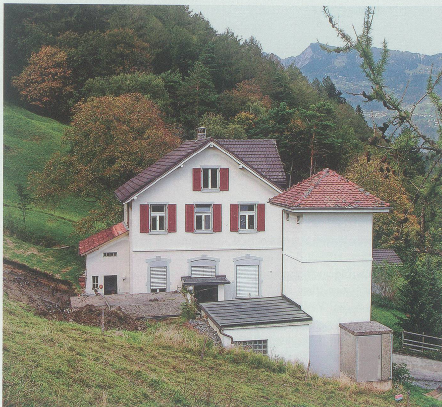
Das Maschinenhaus Azmoos mit dem Transformerhäuschen: 1908 liefen hier zwei Maschinengruppen mit je 60 PS Leistung, die 1926 um eine Gruppe mit 150 PS Leistung ergänzt wurden. Foto Hansjakob Gabathuler, Buchs
