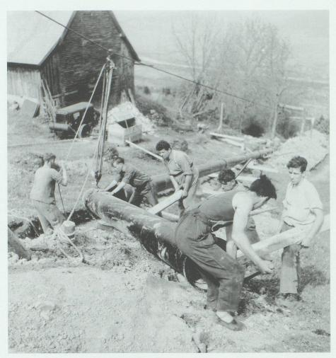
Die Energieknappheit während des Zweiten Weltkriegs bewog das EWB 1942 zu einem Ausbau der Produktionskapazitäten mittels einer Wasserfassung im Tobelbach, dem Bau eines Ausgleichsweihers und einer neuen Druckleitung (Bild). Aufnahme vom 20. Mai
