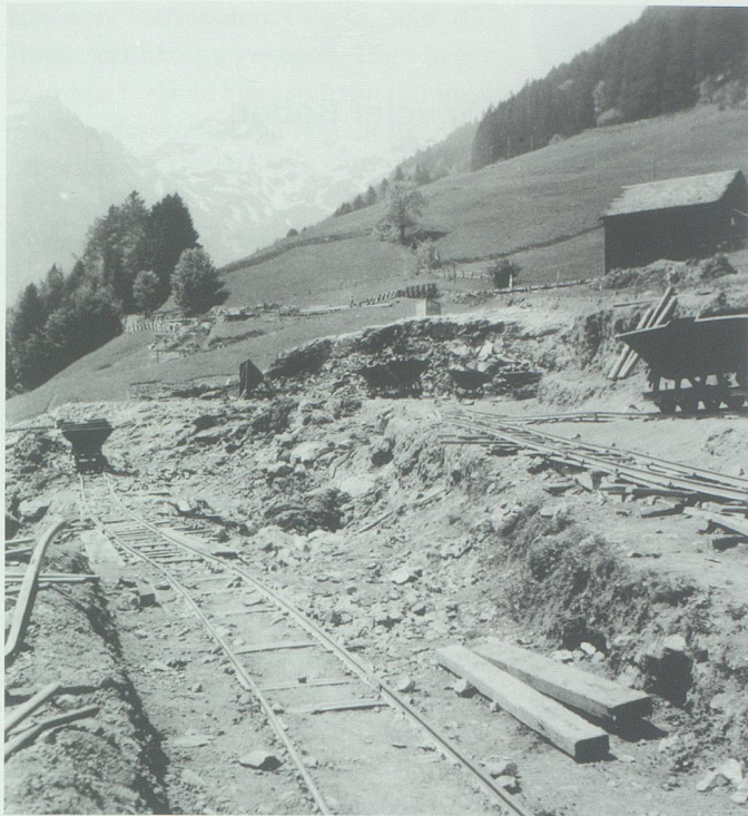
Die Ausbauarbeiten von 1942 dauerten vom 7. April bis zum 17. Dezember. Das Bild zeigt den Stand der Aushubarbeiten für den Ausgleichsweiher Vorderberg am 5. Juni 1942. Archiv Hansruedi Rohrer, Buchs
