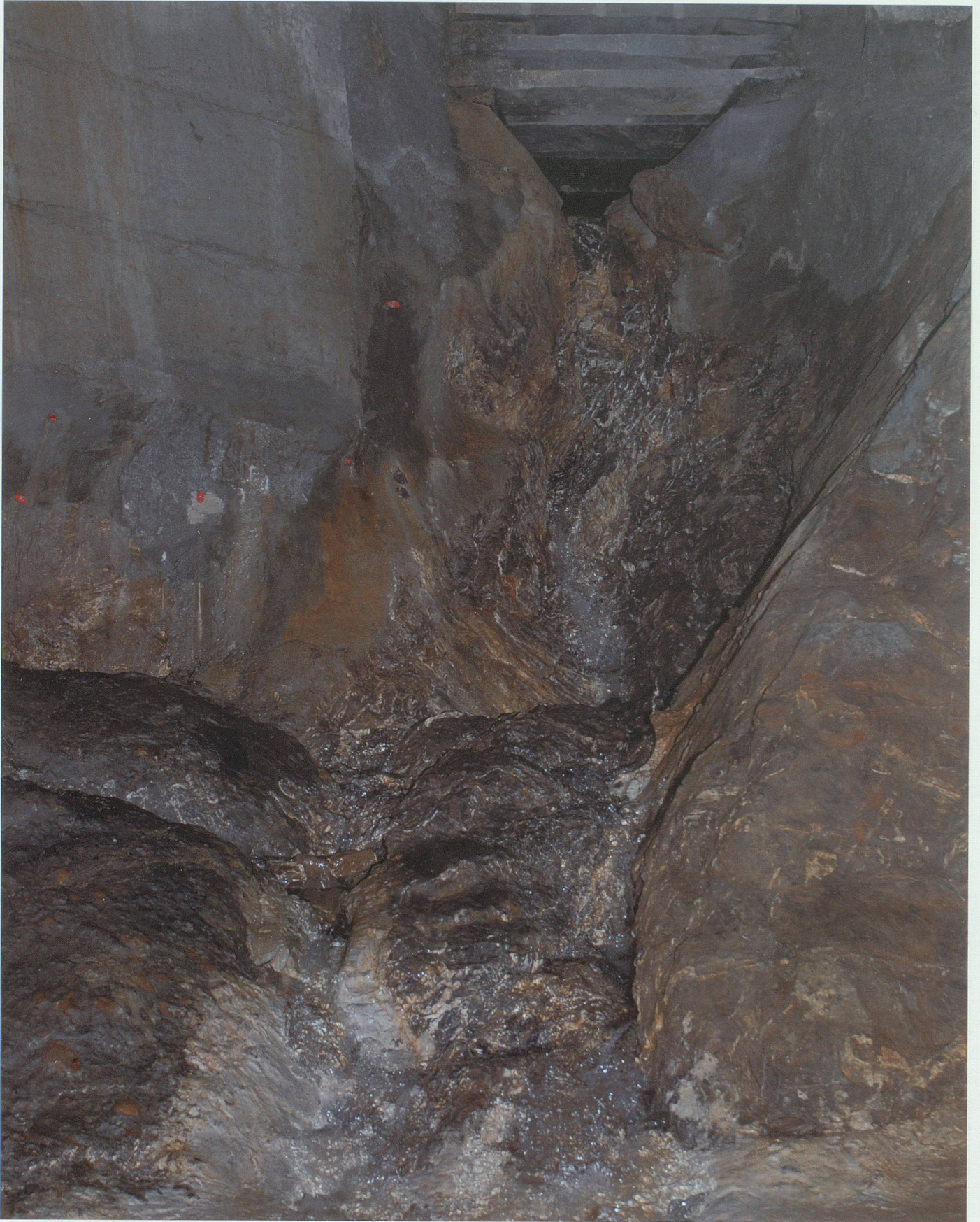
Imalschüel/Sevelen: EWB-Fassung der Felsspaltquelle.
