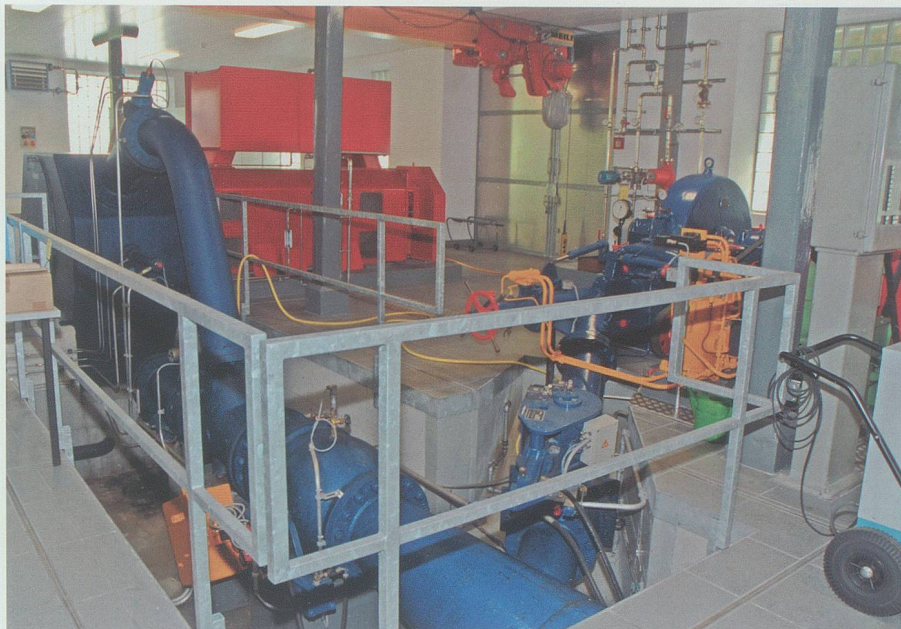
Die jüngste Generation der Grabser «Strommaschinen»: Die 1996 im Kraftwerk Löchli installierte Maschinengruppe hat eine Wirkleistung von zirka 1016 kW. Foto Hans Jakob Reich, Salez
