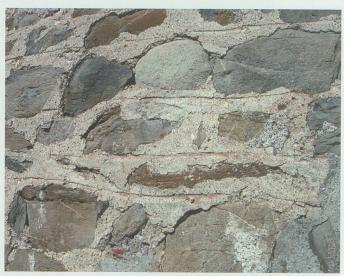
Abb. 16: Beim Rasa-Pietra-Verputz füllte man die Fugen grosszügig mit Mörtel aus und liess die Steinkuppen sichtbar. Bei der Ruine Gräpplang (Flums) brachten die Maurer zudem einen Fugenstrich an.
