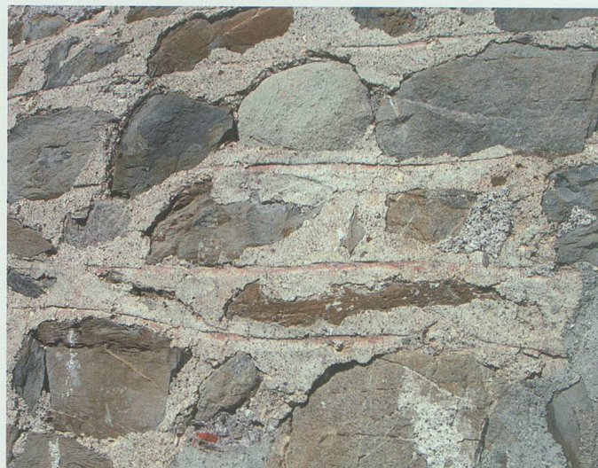
Abb. 16: Beim Rasa-Pietra-Verputz füllte man die Fugen grosszügig mit Mörtel aus und liess die Steinkuppen sichtbar. Bei der Ruine Gräpplang (Flums) brachten die Maurer zudem einen Fugenstrich an.
