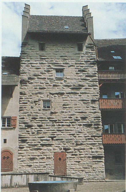
Abb. 38: Der Wehrturm der ehemaligen Burg Bürglen TG ist gut erhalten und besticht durch das sorgfältige Mauerwerk aus Buckelquadern. Der auf der rechten Seite anschliessende Palas wurde massiv umgestaltet.
