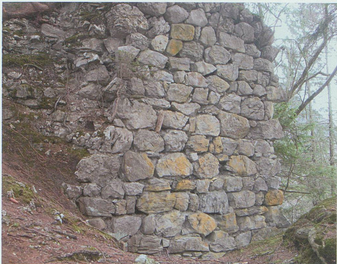
Abb. 15: Der Aussenmantel des Turms auf der Wildenburg bei Wildhaus ist aus mächtigen Steinblöcken lagerhaft aufgemauert worden. Der Mörtel ist zum Teil bis weit ins Mauerinnere hinein ausgewaschen.
