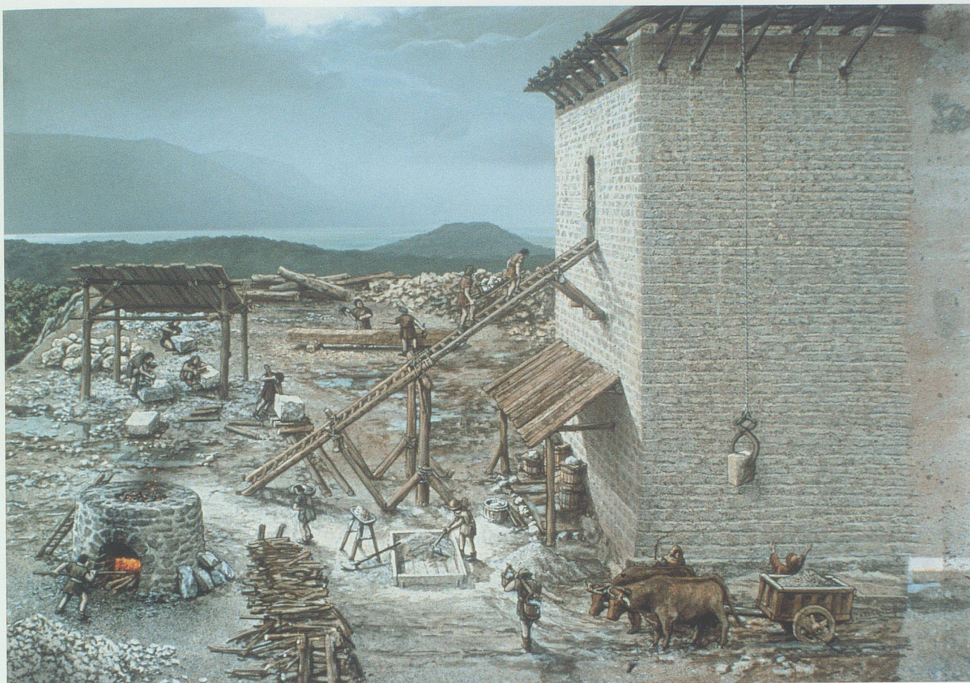
Abb. 14: Steinmetzen, Maurer und Zimmerleute galten als Facharbeiter, die von Bau zu Bau weitergereicht wurden. Abhängige Bauern wurden in angemessener Weise für Handlangerdienste beigezogen. Im Ofen wurde Kalk für die Herstellung von Mörtel gebrannt.
