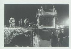
25./26. Februar: Beim SBB-Übergang Ackerweg in Buchs wird die vorgefertigte Unterführung gesetzt.
