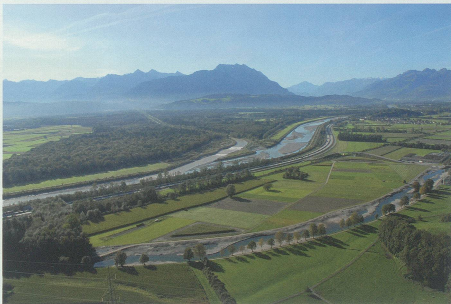
Möglichkeiten der ökologischen Aufwertung in Verbindung mit einer Verbesserung des Hochwasserschutzes ergeben sich am Werdenberger Binnenkanal – wie hier beim Projekt «Hochwasserschutz und Ökologie im Einklang» am Rheintaler Binnenkanal in Rüthi.
