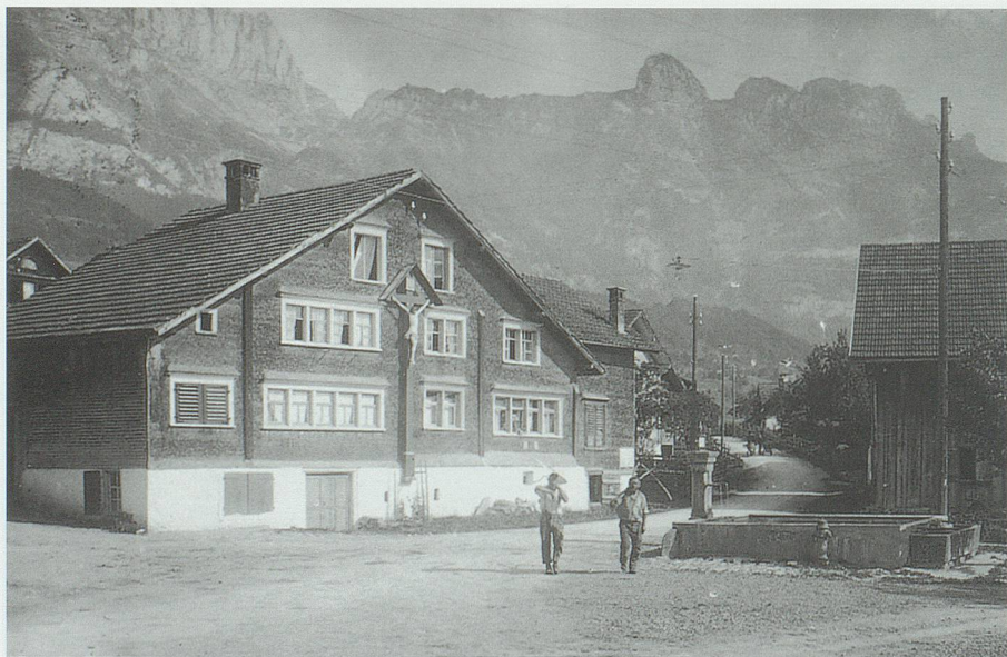
Der Dörfliplatz um 1900 mit Blick Richtung Sax. In der Mitte der Gasenzler Brunnen, rechts das Brandobjekt.
