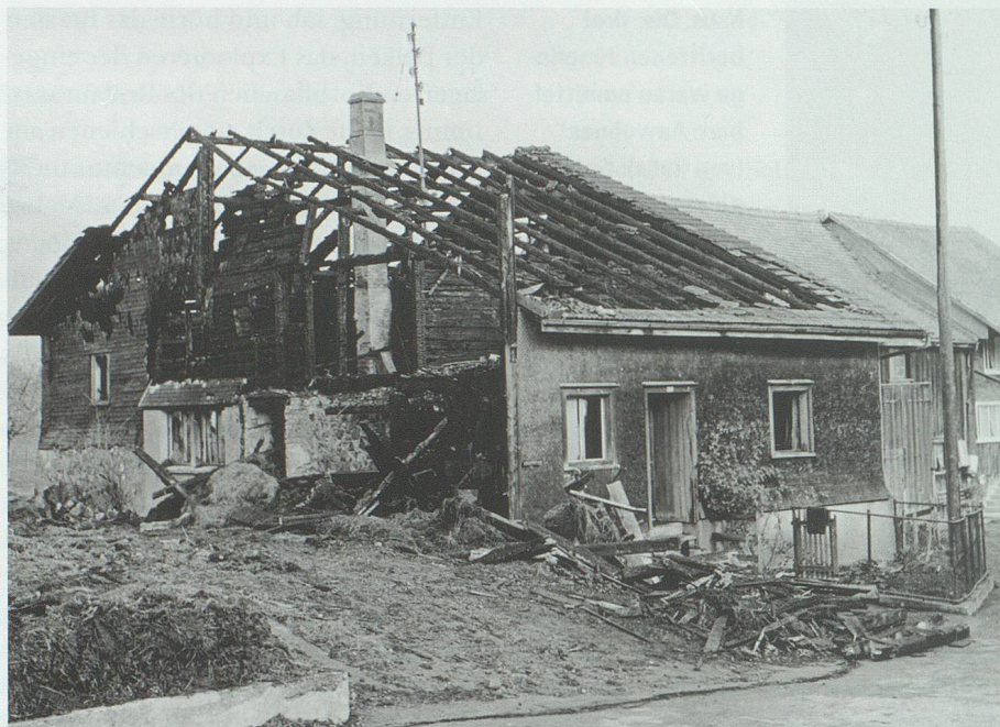
Das Brandobjekt von Westen. Der Stall (links) wurde völlig zerstört, und das daran anschliessende Haus brannte bis auf die Stube aus. Bild im Staatsarchiv St.Gallen
