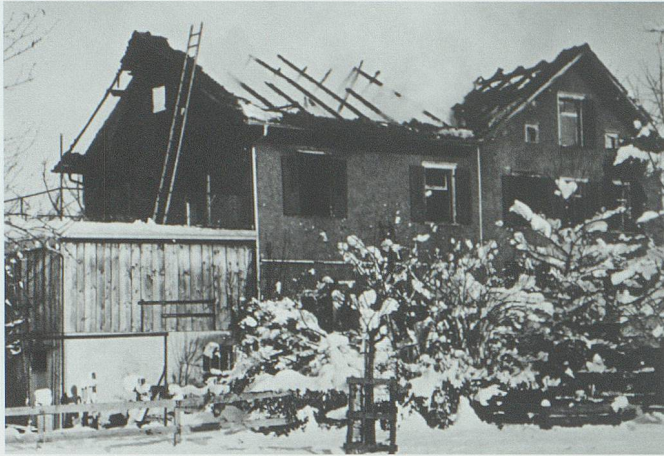
9. Dezember 1967. Zündhölzchen in Kinderhand waren am Schläppliweg in Buchs die Ursache des Brandes dieses Zweifamilienhauses. Bild im Archiv Hansruedi Rohrer, Buchs
