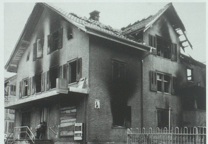
9. September 1961. Beim Brand der Liegenschaft Kubik in Buchs gab es mehrere Verletzte. Bild im Archiv Hansruedi Rohrer, Buchs
