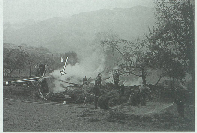
18. Juni 1951. Aufräum- und letzte Löscharbeiten in der rauchenden Brandruine in Grabs-Ritsch. Bilder im Staatsarchiv St.Gallen (Brandakten Grabs 1/1932–1975)
