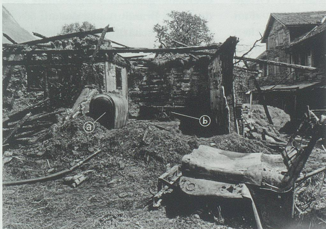
21. Juni 1965. Ein «Langschluss» in der elektrischen Anlage eines Jeeps führte zum Brand in der Gärtnerei Berger in Sennwald. Bild im Staatsarchiv St.Gallen (Brandakten Sennwald 1/ 1932–1971)
