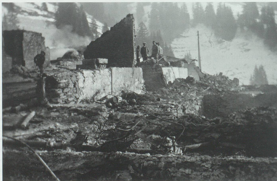
24./25. November 1935: Was vom einst so stolzen Kurhaus Palfries nach dem Brand noch übrig blieb. Bild im Staatsarchiv St.Gallen (StASG R 171 F3 Bez. Werdenberg)
