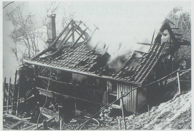
24. Januar 1970. Über eine halbe Million Franken Schaden war die Folge einer versehentlich unter Strom gelassenen Heizdecke in Sax-Oberrüti. Bild im Staatsarchiv St. Gallen
