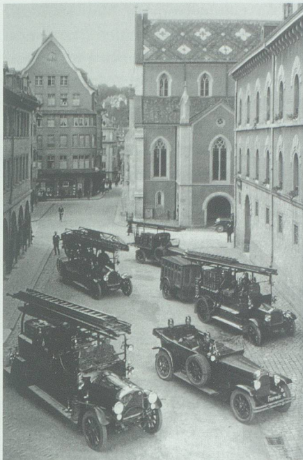
1934 verfügte die Berufsfeuerwehr der Stadt St.Gallen über diesen motorisierten Löschzug, bestehend aus einem Kommandowagen, zwei Automobilspritzen, einer Automobilleiter und einem Materialfahrzeug. Aus KFVSG 2002
