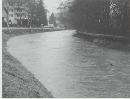
13./14. Januar: Starke Niederschläge lassen die Bäche – hier den Buchser Giessen – anschwellen. Zu grösseren Schäden kommt es aber nicht.
