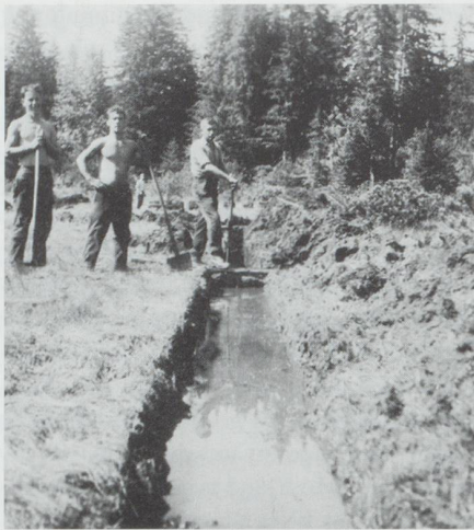
Hochmoor Gamperfin: Bau des Entwässerungsgrabens zur Vorbereitung des Torfabbaus in den 1940er Jahren. Bilder aus Sieber 1983.
