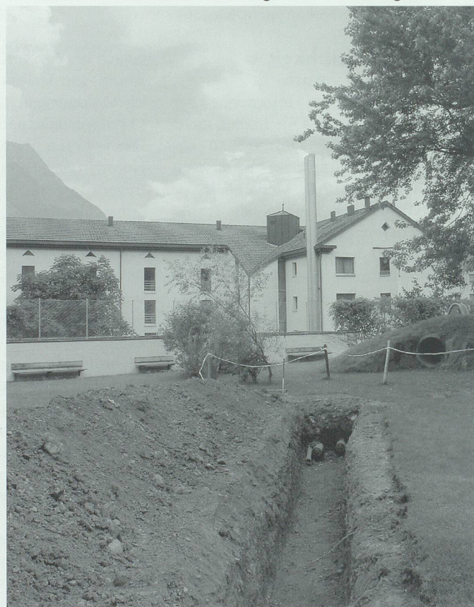
Verlegen der Wärmeleitung des Nahwärmeverbundes Azmoos. Die Heizzentrale (im Hintergrund) befindet sich im Gebäude der Alterswohnungen an der Feldgasse.
