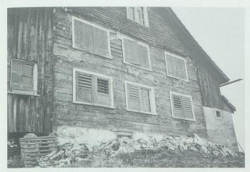
Das alte Schindelkleid wird demontiert. Darunter kommt eine gut erhaltene Strickwand zum Vorschein. Sie gehört zum ursprünglichen Bestand des Gebäudes, während der Anbau links später hinzukam.
