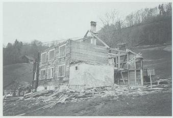
Sie tut schon etwas weh, diese «Operation». Der gestrickte Hauptbaukörper ist noch gut, der bergseitige Küchenanbau jedoch ist besonders im Sockelbereich sehr schlecht. Auch der sich im Vordergrund befindende gemauerte Schweinestall wird noch abgebrochen.
