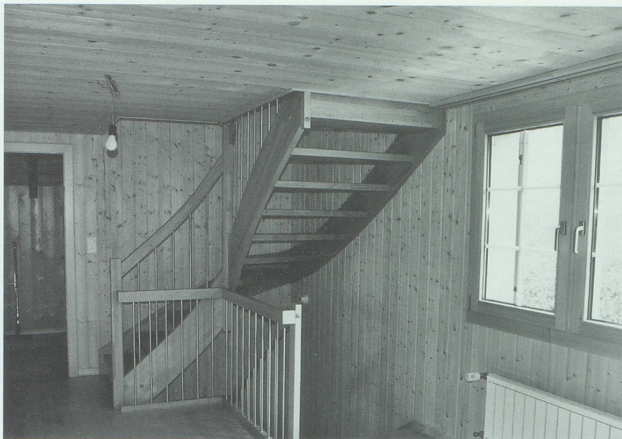
Diese Treppe (Bild links) ist etwas steil, und die Treppenkanten sind massiv ausgelaufen. Die neue Treppenkonstruktion (rechts) weist ein ideales Treppenverhältnis auf.
