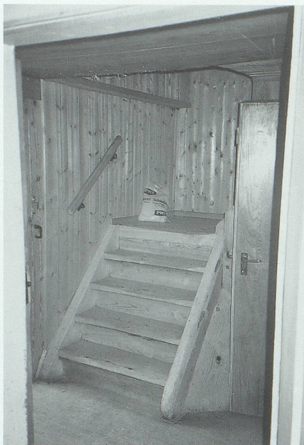
Diese Treppe (Bild links) ist etwas steil, und die Treppenkanten sind massiv ausgelaufen. Die neue Treppenkonstruktion (rechts) weist ein ideales Treppenverhältnis auf.
