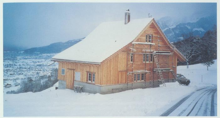
Die Qualität eines Holzbaus richtet sich nach der Konstruktionsart. So darf das Holz, wenn es dauerhaft sein soll, nicht in den Spritzwasserbereich des Terrains reichen, und ein konstruktiver Holzschutz ist das A und O für eine lange Lebensdauer des Holzhauses.
