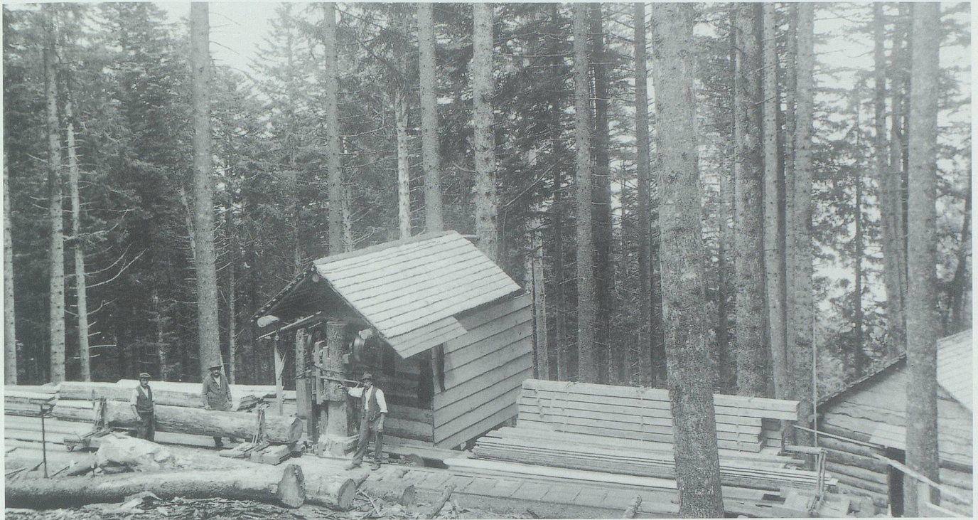
Der Einschnitt des Holzes für den Bau von Alpgebäuden erfolgte auch mittels sogenannter Waldsägen. Das Bild vom 21. Juni 1920 zeigt eine solche in Oberplätsch/Sevelen eingerichtete Anlage. Bild: Sammlung Werner Hagmann, Zürich.
