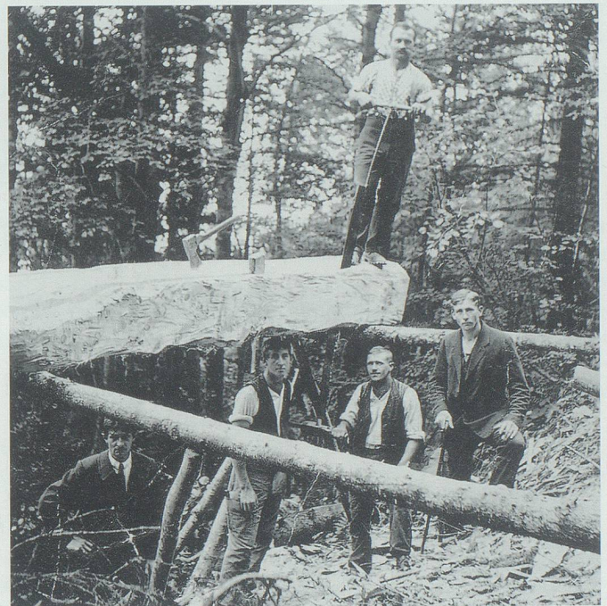
Noch in den ersten Jahrzehnten des 20. Jahrhunderts wurden Balken für den Bau von Alpgebäuden im nahe gelegenen Bergwald in anstrengender Handarbeit zugesägt, wie dies das Bild aus den 1920er Jahren dokumentiert. Es entstand anlässlich des Baus des Rieter Scherms im Rieterwald/Cholplatz (Gemeinde Wartau). Oben an der Säge Hans Heeb, Zimmermann, unten an der Säge rechts Jöri Schlegel und links Emil Caprez; ganz rechts (mit Stock) Baumeister Hans Schmidt. Bild in Privatbesitz.
