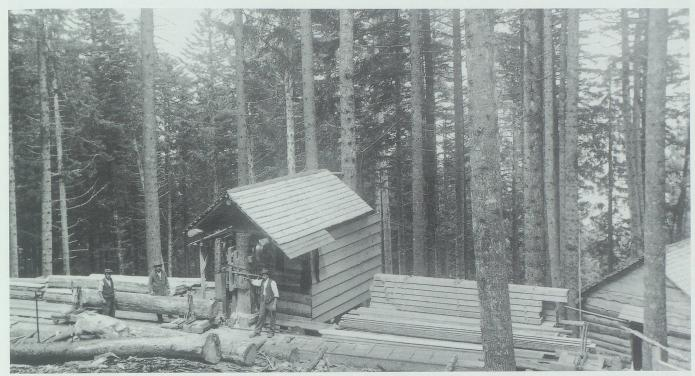
Der Einschnitt des Holzes für den Bau von Alpgebäuden erfolgte auch mittels sogenannter Waldsägen. Das Bild vom 21. Juni 1920 zeigt eine solche in Oberplätsch/Sevelen eingerichtete Anlage. Bild: Sammlung Werner Hagmann, Zürich.
