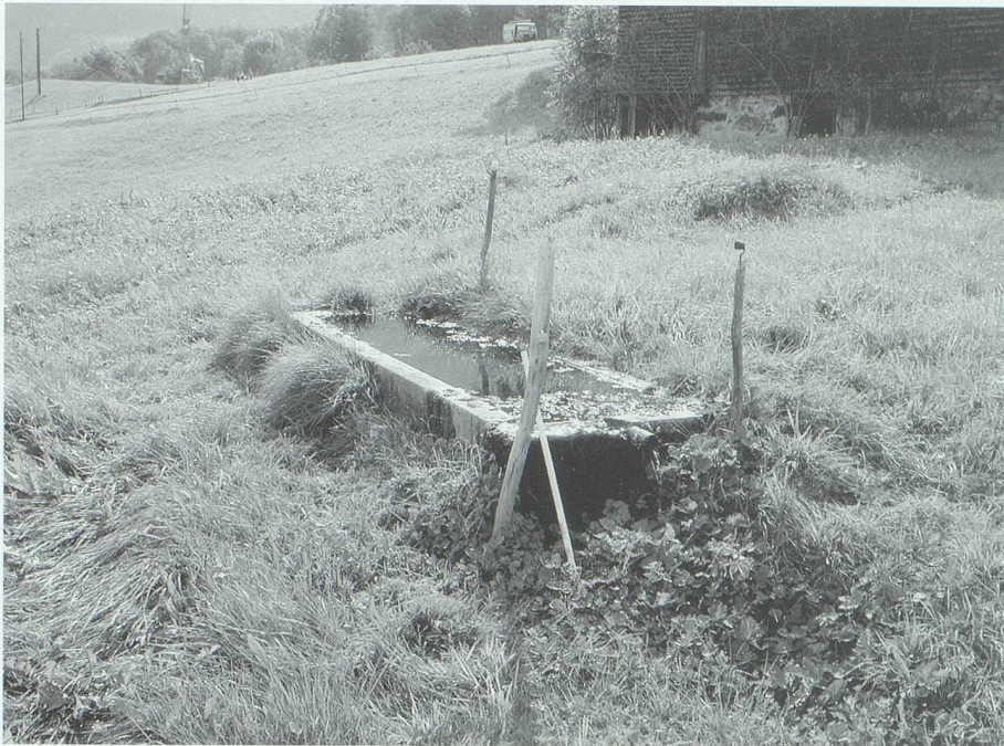
Hier ist das Streitobjekt, der Hofbrunnen. Die Wasserröhre mündet links hinten direkt über dem Trogrand, der Abfluss ist gut sichtbar (vorne rechts).
